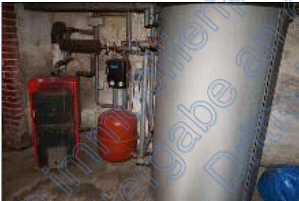
Festbrennstoffkessel und Wärmespeicher
