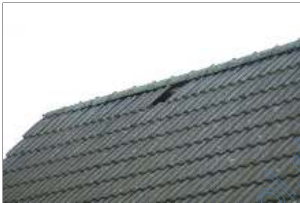
Schäden an der Dachdeckung
