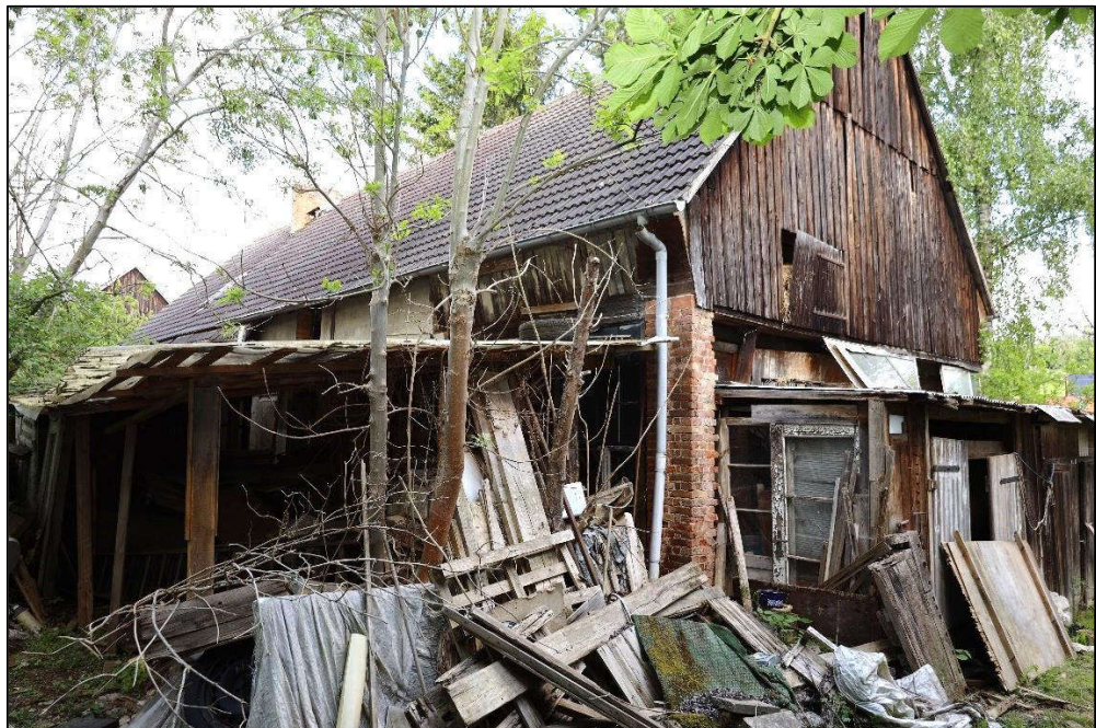
Südostansicht – Scheunenanbau am Wohnhaus
