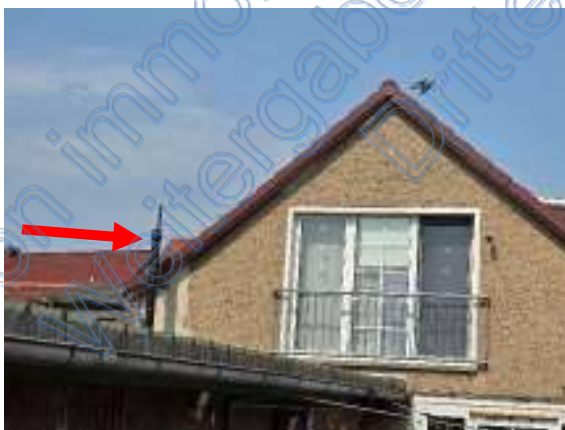
Östlicher Giebel, links Abgasrohr der Heizung
