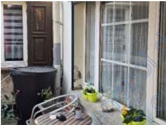
Feuchteschäden in der Fensterlaibung
