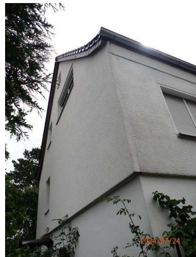
nordorientierter, rückseitiger Giebel mit Wärmedämmverbundsystem
