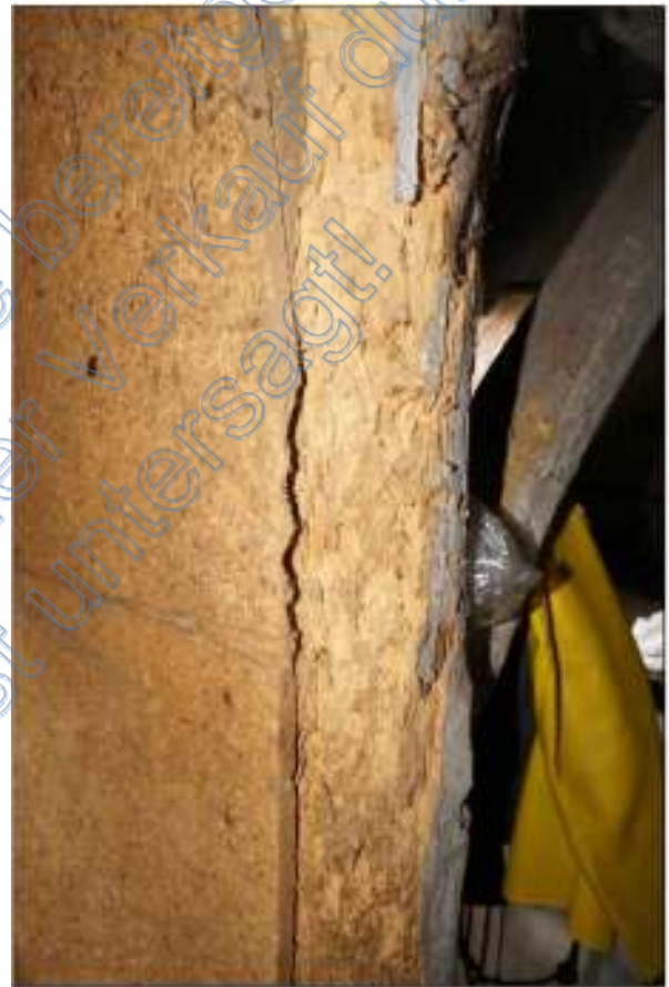
Schäden an Dachbalken
