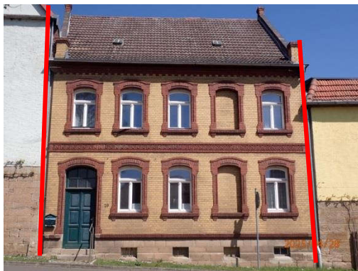
Ansicht von der Straße Fassade etwa südorientiert
