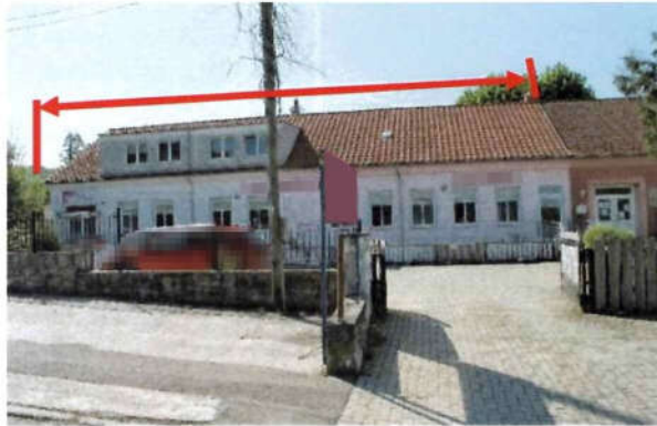
Straßenansicht mit Zufahrt
