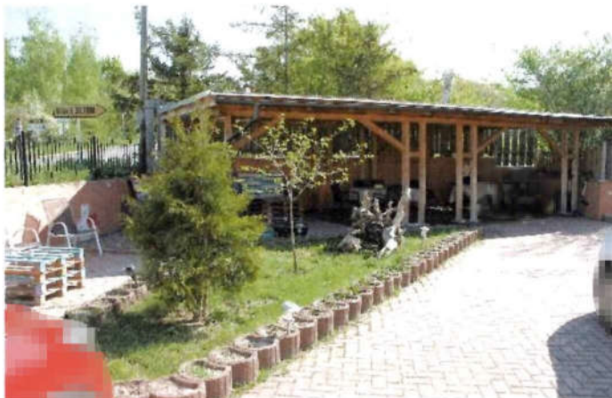
Hofansicht des Carport
