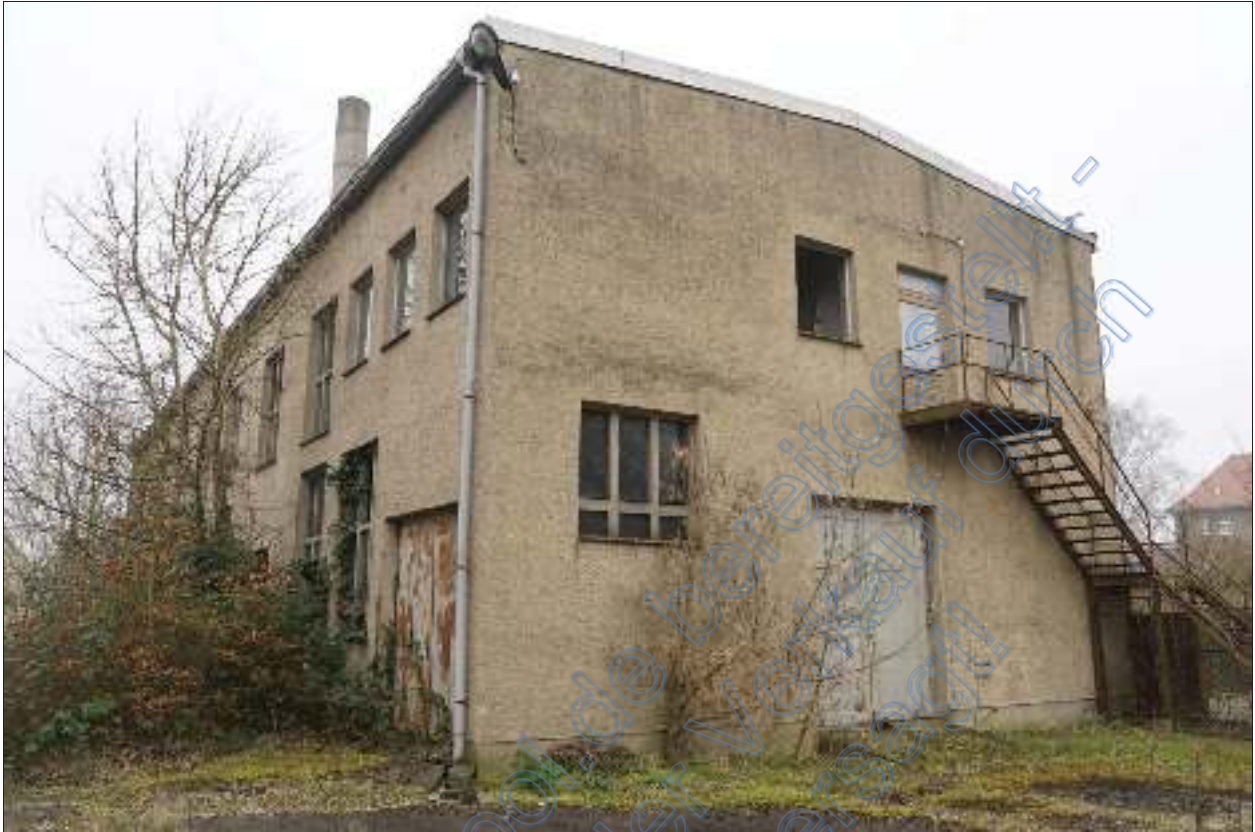
nördlicher bzw. auf das Bewertungsgrundstück überbauter Teil des Heizwerks
