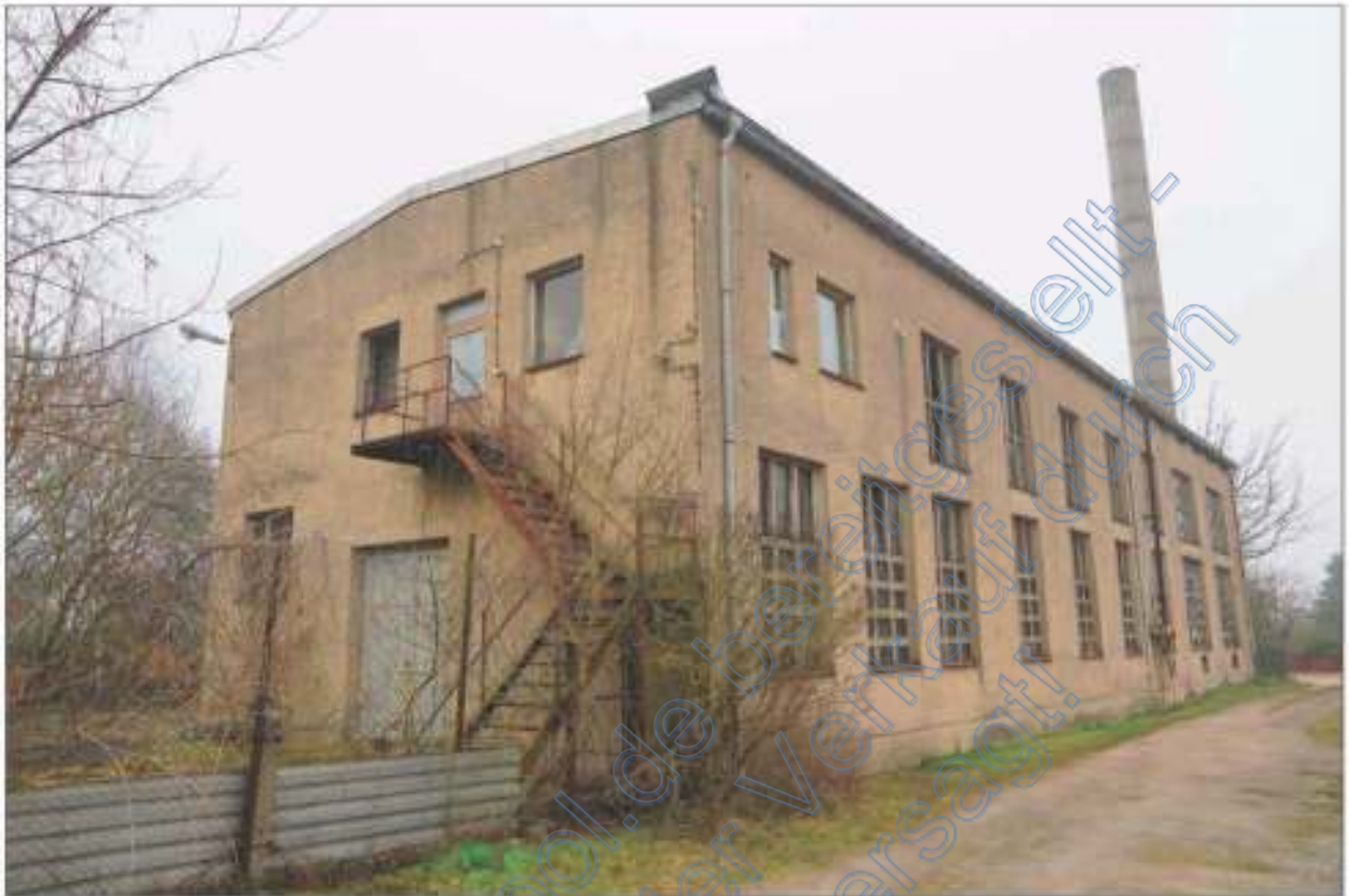
westliche und nördliche Gebäudefront des Gewerbegebäudes
