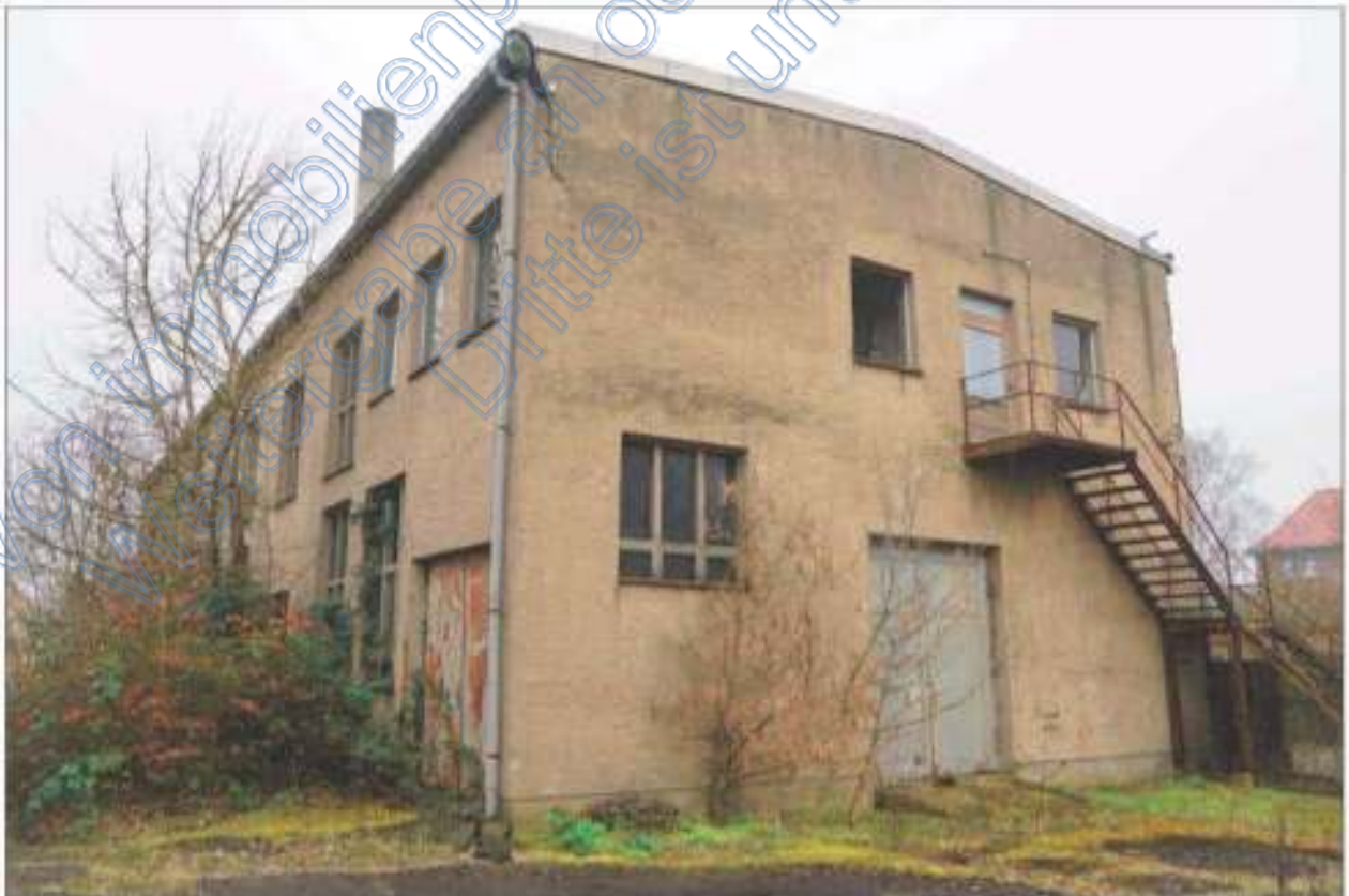
östliche und nördliche Gebäudefront des Gewerbegebäudes
