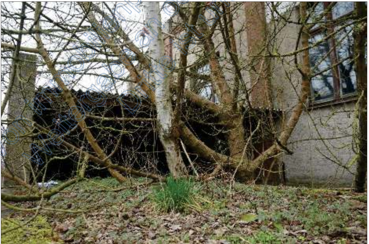
Blick über die Grundstücksmauer auf den Unterstand o.ä.
