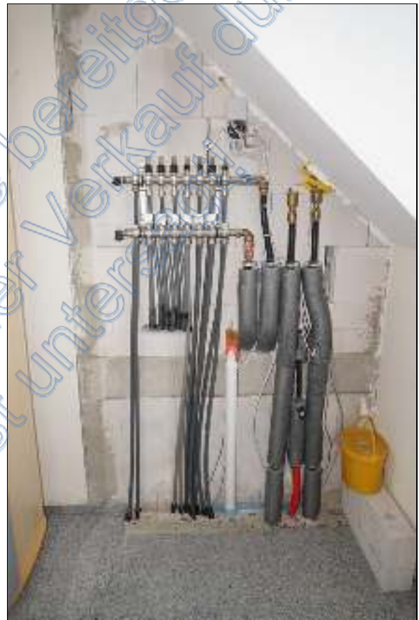
Verteilung der Fußbodenheizung
