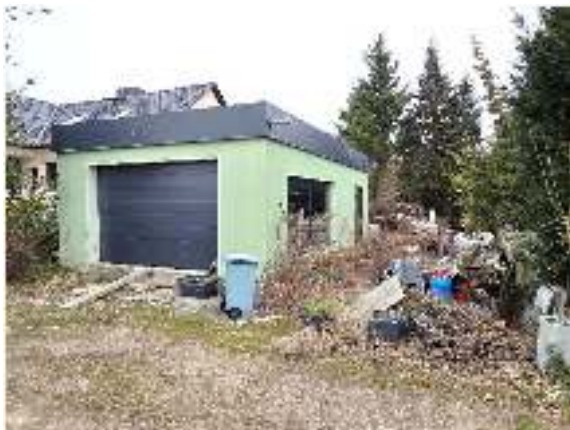
Grundstück lfd. Nr. 1 - Vorderansicht
