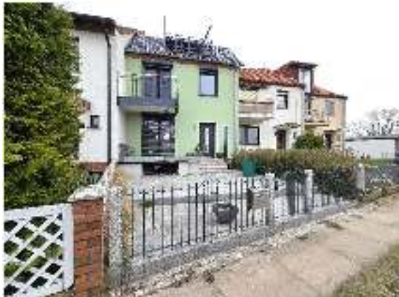
Grundstück lfd. Nr. 2 - Vorderansicht
