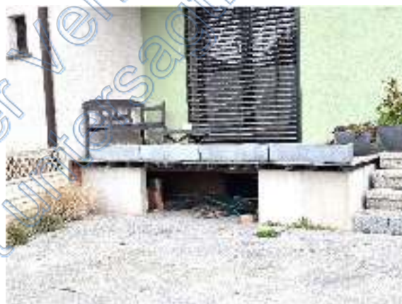
Grundstück lfd. Nr. 2 – Terrasse EG
