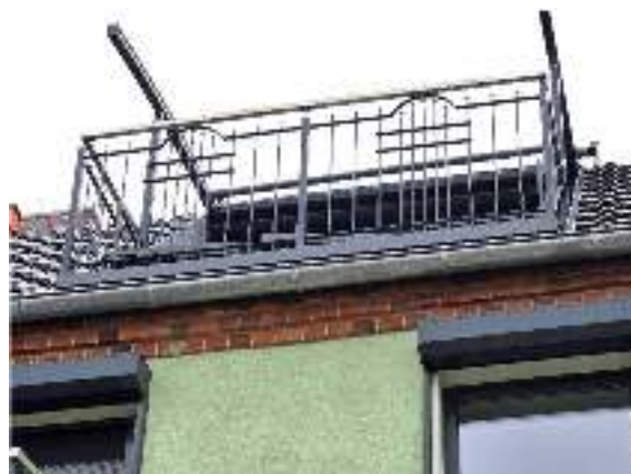
Grundstück lfd. Nr. 2 - Dachaustritt
