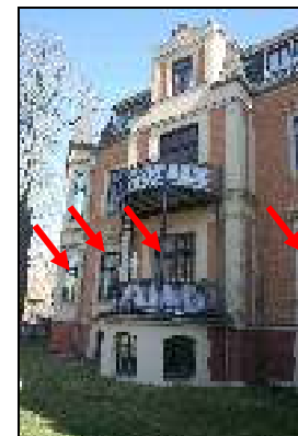
6 Nahansicht 1 Gebäudeflügel am Advokatenweg Haus Nr. 44, Lage des Teileigentums Nr. 2 im EG (Hochparterre) rot markiert, mit Balkon über UG auf der Westfassade
