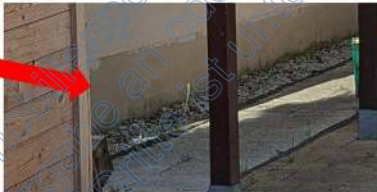
schadhafter Sockelputz
