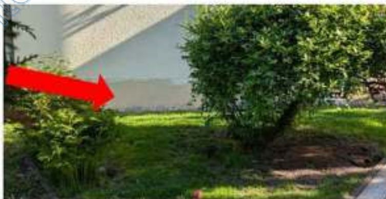
schadhafter Sockelputz
