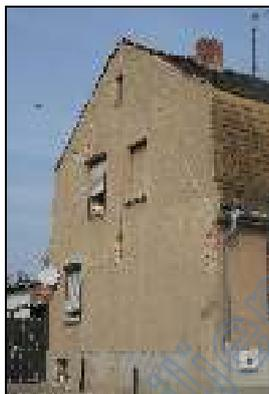
3 Ansicht 1 südwestlicher Giebel der Doppelhaushälfte mit leichter Ausbauchung im oberen Drittel, einen klaffenden (von außen nach innen) durchgehenden Riss und Putzabplatzungen, von der Grundstückszufahrt aus
