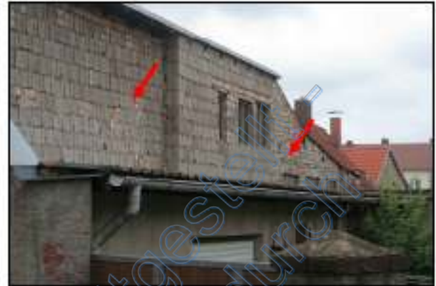
Nahansicht östliche, unverputzte Giebelwand (rot markiert). Bewertungsobjekt zum Fremdfurstück 54/1 hin
