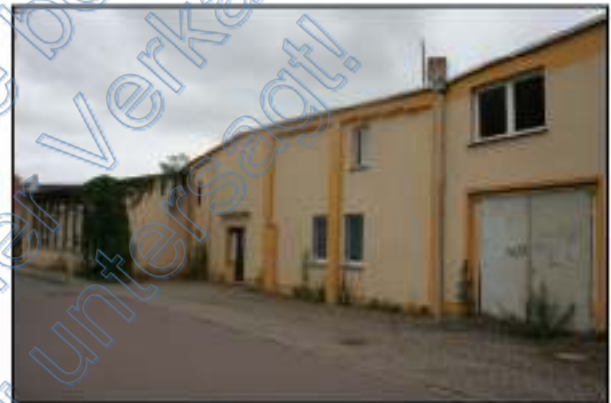
Nahansicht von Foto 3, Gesamtgebäudekomplex entlang der Schulstraße
