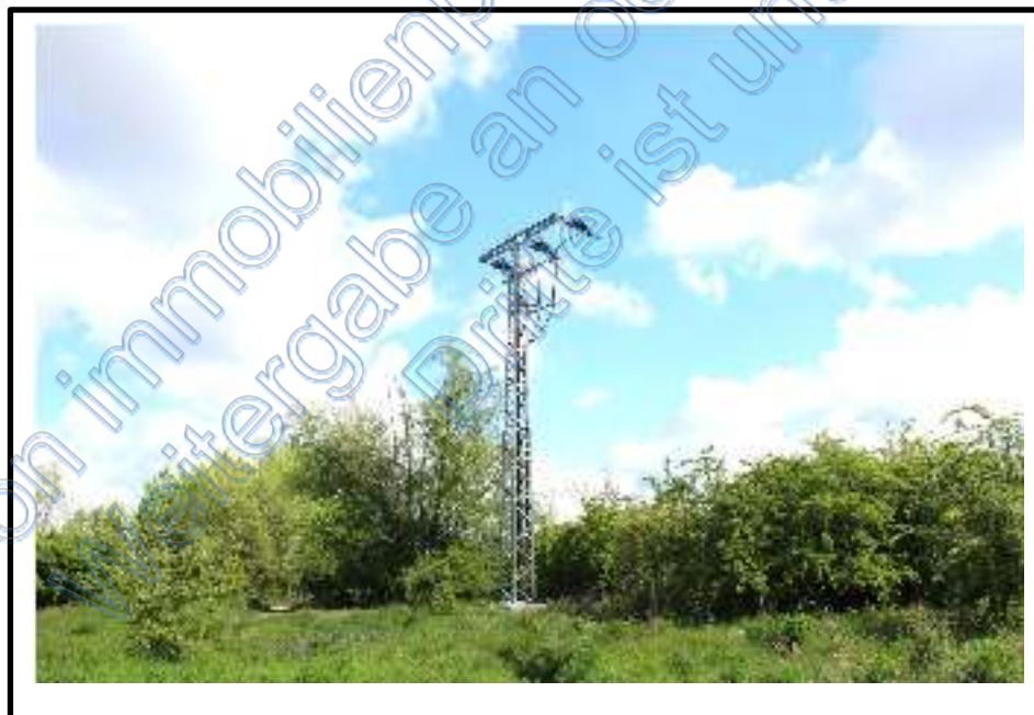
Bild 2 Detailansicht mit Blick auf Bewertungsobjekt mit Aufwuchs und Freileitungsmast
