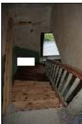
Treppe vom Erdgeschoss zum Dachgeschoss
