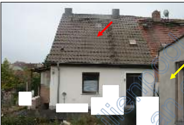
Rückwärtige Ansicht 2 Doppelhaushälfte (rot markiert) mit gedeckter Kelleraußentreppe, Terrassenübergang zum ausgebauten Nebengebäude (gelb markiert)
