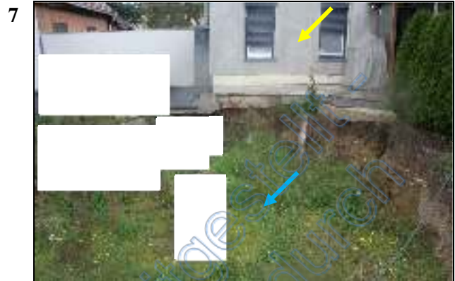
Ausgebautes Nebengebäude (gelb markiert), im Vordergrund Aushubloch für geplanten Pool (blau markiert), (siehe Flurkarte Seite 3, Fotostandpunkt 8)
