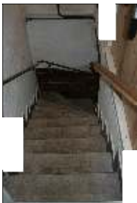
Treppe vom Kellergeschoss zum Erdgeschoss
