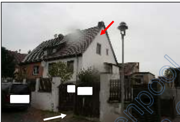
Südostansicht Bewertungsgrundstück mit Doppelhaushälfte (rot markiert) und Grundstückszufahrt (weiß markiert) vom Schwedenweg aus
