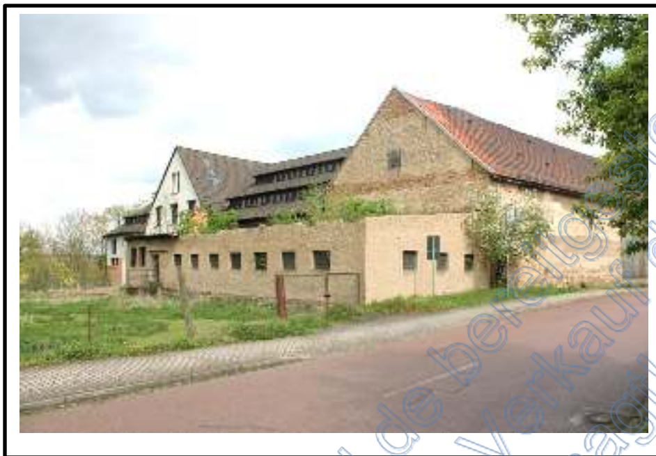
Bild 1 Detailansicht mit Blick auf Lage der Bewer- tungsgrundstücke Gemarkung Salzmünde Flur 3, Flurstück 4/2 und Flur 4, Flurstück 34/71 von der Straße aus gesehen
