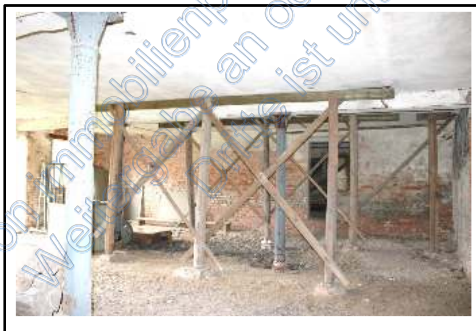
Bild 2 Detailansicht mit Blick in Innenraum von Scheunengebäude 2 (Gebäudeteil G/F)
