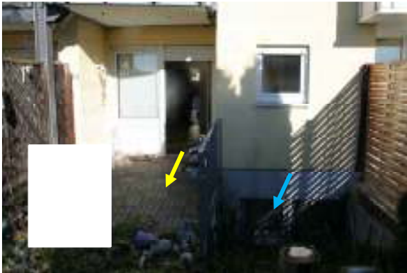
Rückwärtige Ansicht Terrassenzugang vom Wohnzimmer aus sowie Abgrabung für Belichtung des Kellers Nr. 7, Kellerfenster (blaue Markierung)
