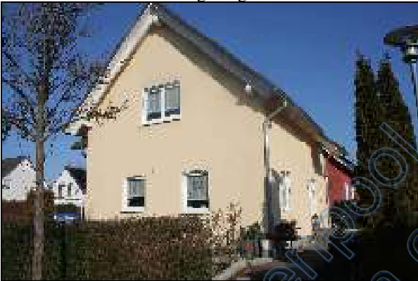
Südansicht mit Giebel (Südwestfassade) vom Smaragdweg aus, etwas erhöht liegender Eingang zum Wohnhaus auf der Südostfassade
