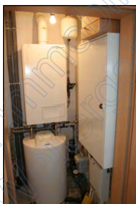
Ansicht Hausanschluss- bzw. Heizungsraum mit WW-Boiler
