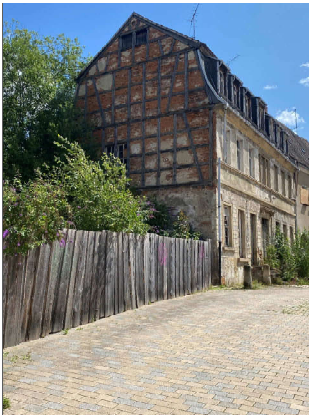
Gebäudegiebel des Mehrfamilienhauses, Ansicht aus Richtung Nordwesten
