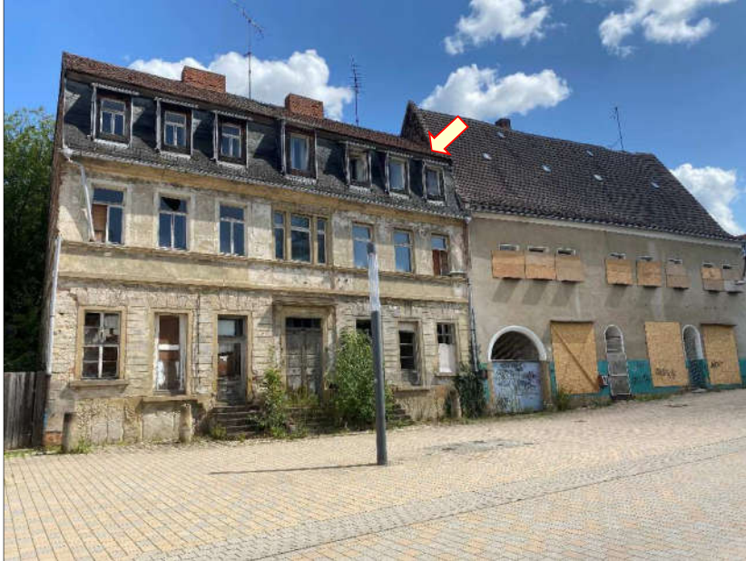
Blick vom „Brühl“ aus Richtung Westen auf das ⇒ Mehrfamilienhaus mit zwei ehemaligen Gewerbeeinheiten im Erdgeschoss
