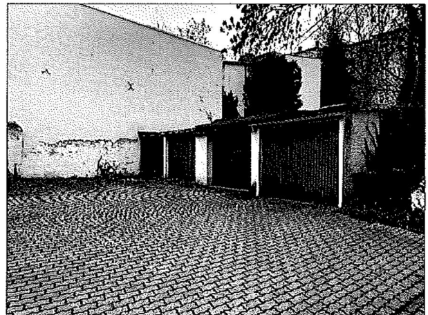
Reihengaragen im Bereich der südwestlichen Grundstücksecke, Ansicht aus Richtung Nord- osten
