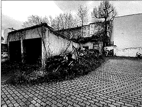
Nebengebäude im Bereich der südöst- lichen Grundstücksecke, Ansicht aus Richtung Nordwesten
