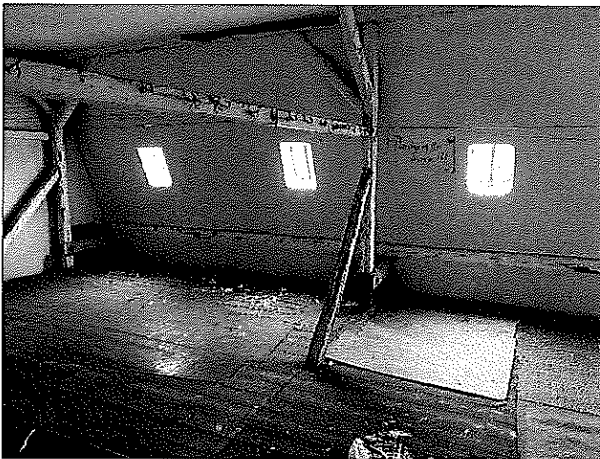
baulicher Zustand des Dachgeschosses
