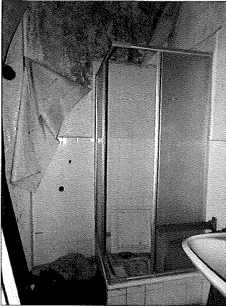
ehemaliges Bad der Wohnung Nr. 3
