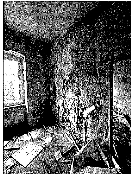
baulicher Zustand der Wohnräume der Wohnung Nr. 3 im 1. Obergeschoss, ⇒ massiver Schwarzschildbefall
