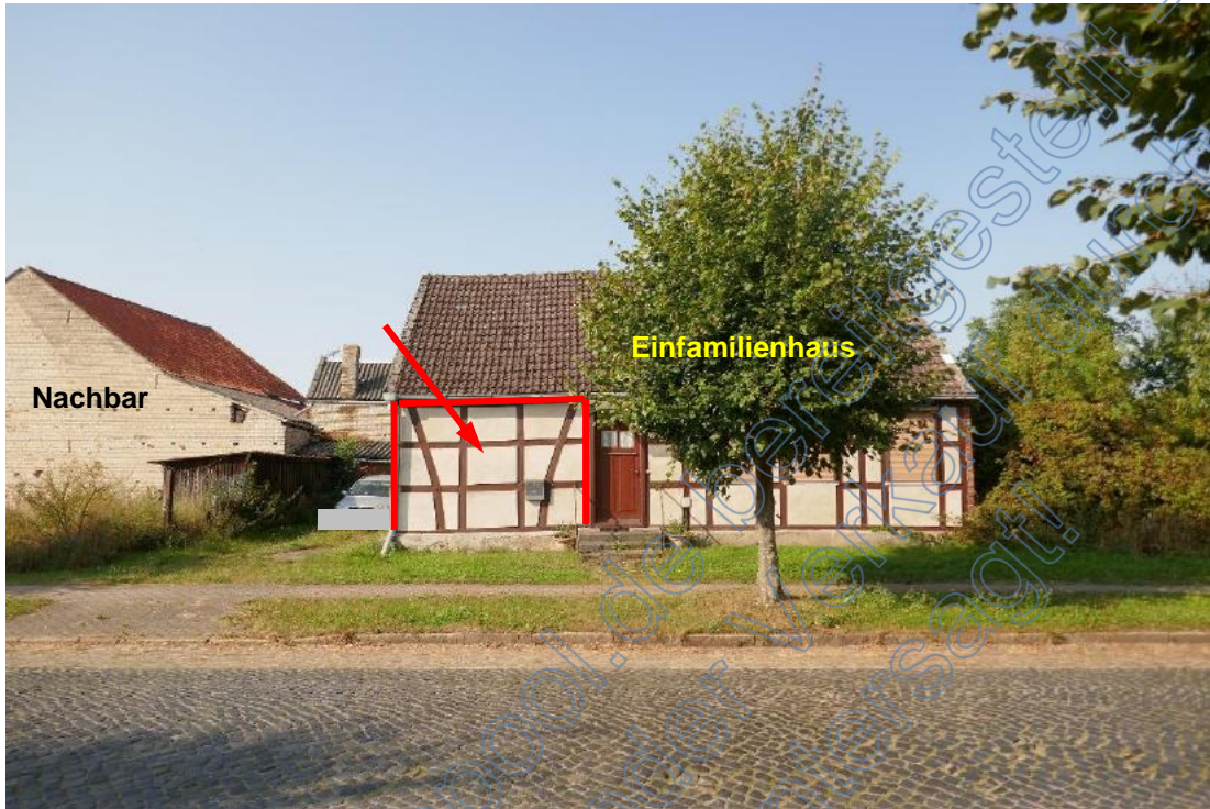
Foto 1, Straßensicht, Einfamilienhaus, rot umrandet Wirtschaftsbereich (Pfeil), Nordostansicht
