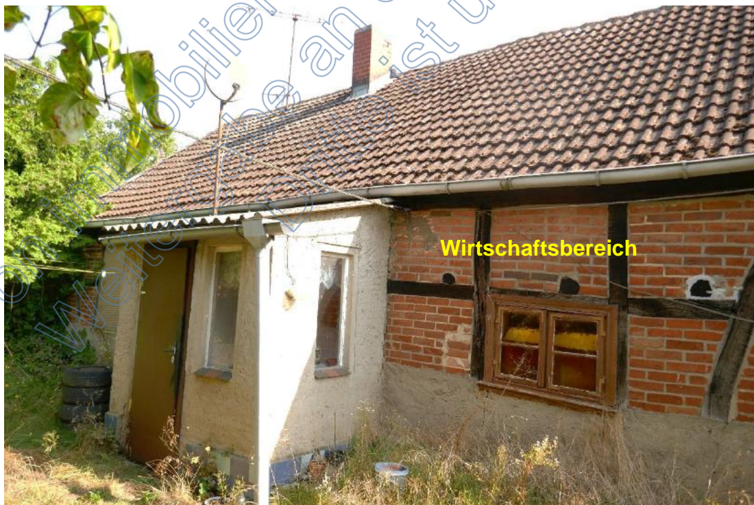
Foto 6, Rückseite Einfamilienhaus mit Windfanganbau und Wirtschaftsbereich, Südostansicht
