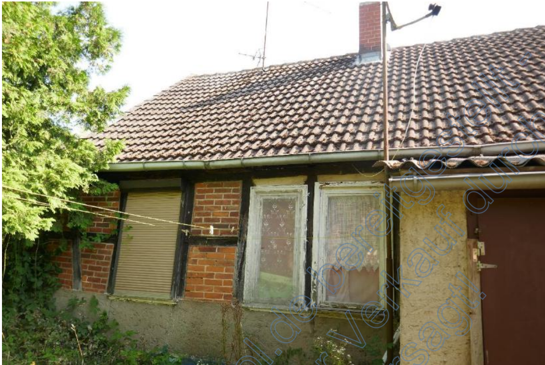
Foto 7, Rückseite Einfamilienhaus Wohnbereich, Südostansicht
