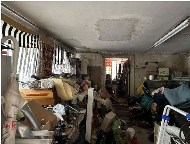
westlicher Gebäudekörper mit Blick nach Osten
