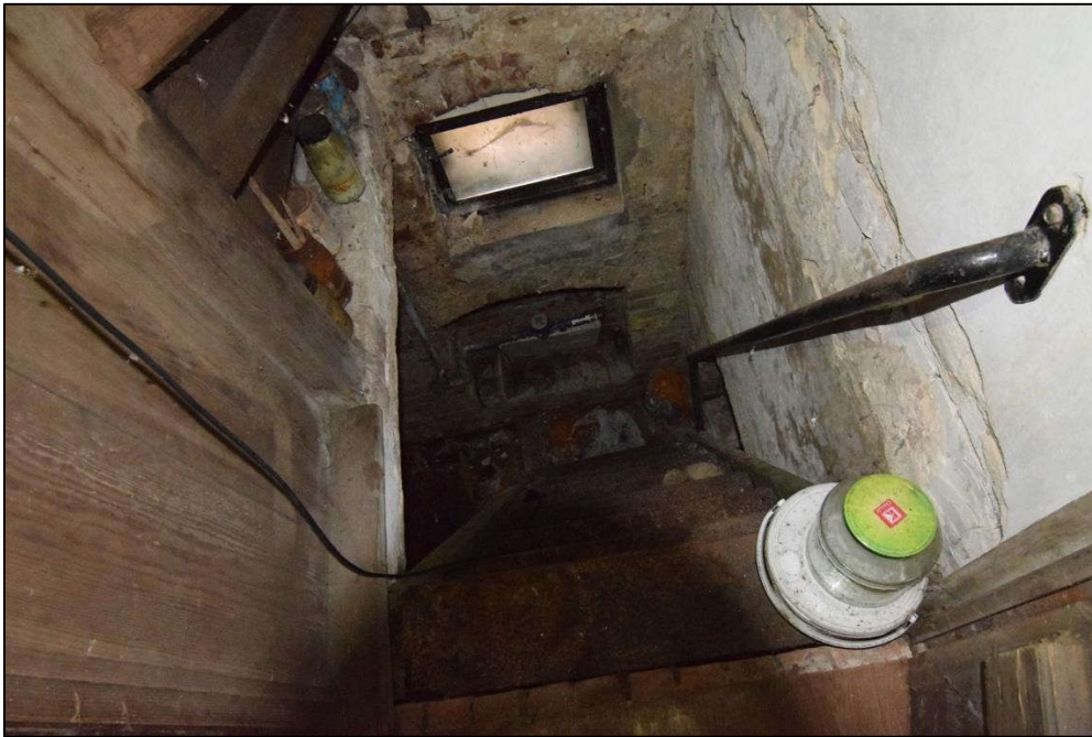
Kellerabgang/ kleiner Bereich unterkellert
