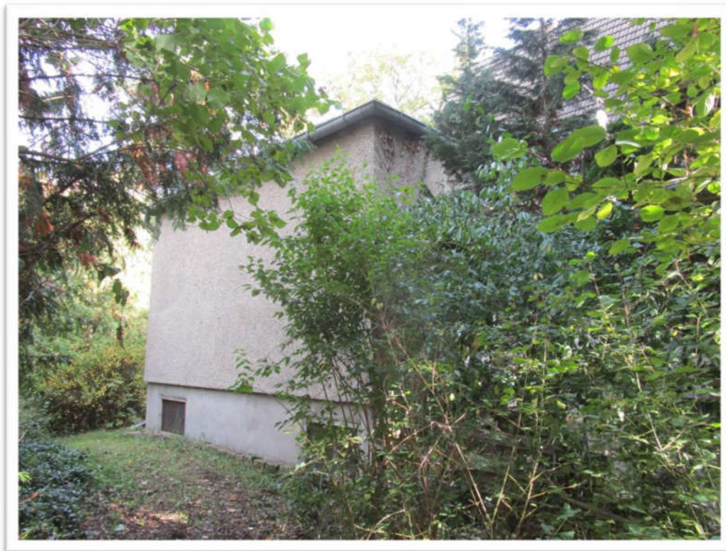
Bild 10: Wohnhaus Nr.8 – Anbau Westseite
