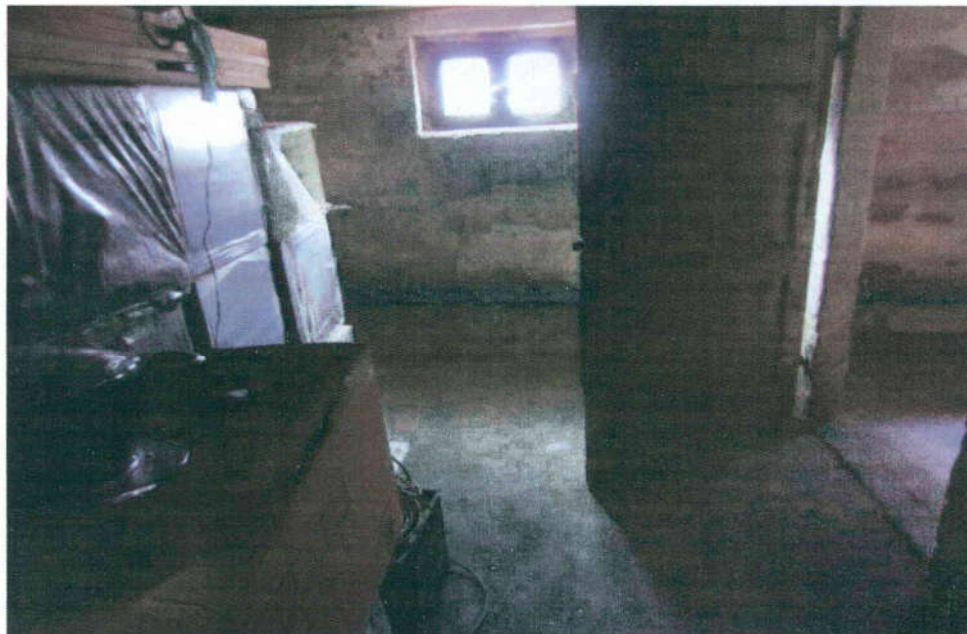
BILD 21: Hohenzitz, Im Winkel 4, Scheune, Keller
