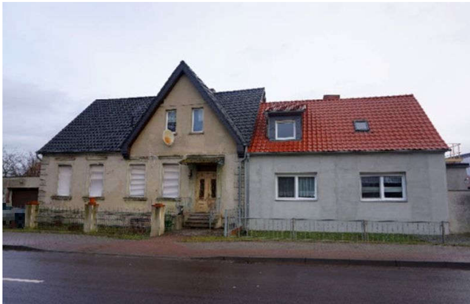
Bild 1: Straßenansicht des Bewertungsgrundstücks mit dem Nachbarobjekt Pareyer Straße 9
