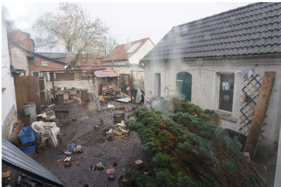
Bild 10: Hofbereich und Nebengebäude
