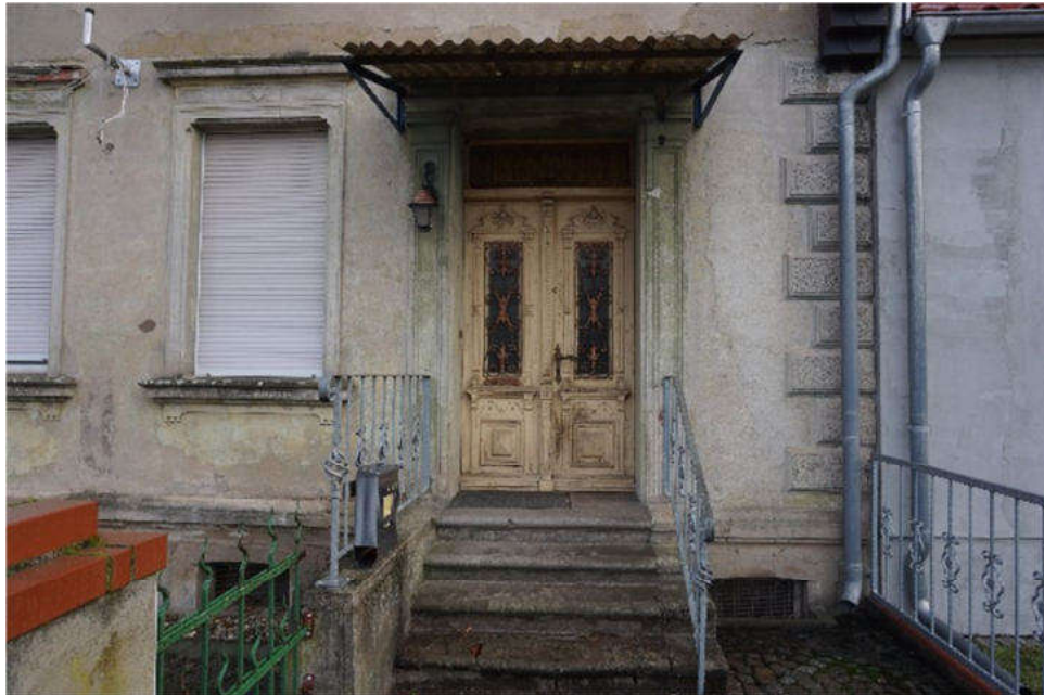
Bild 5: Ansicht des Hauseingangsbereiches
