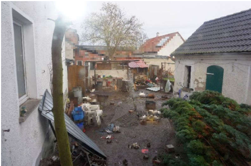
Bild 9: Hofbereich und Nebengebäude
