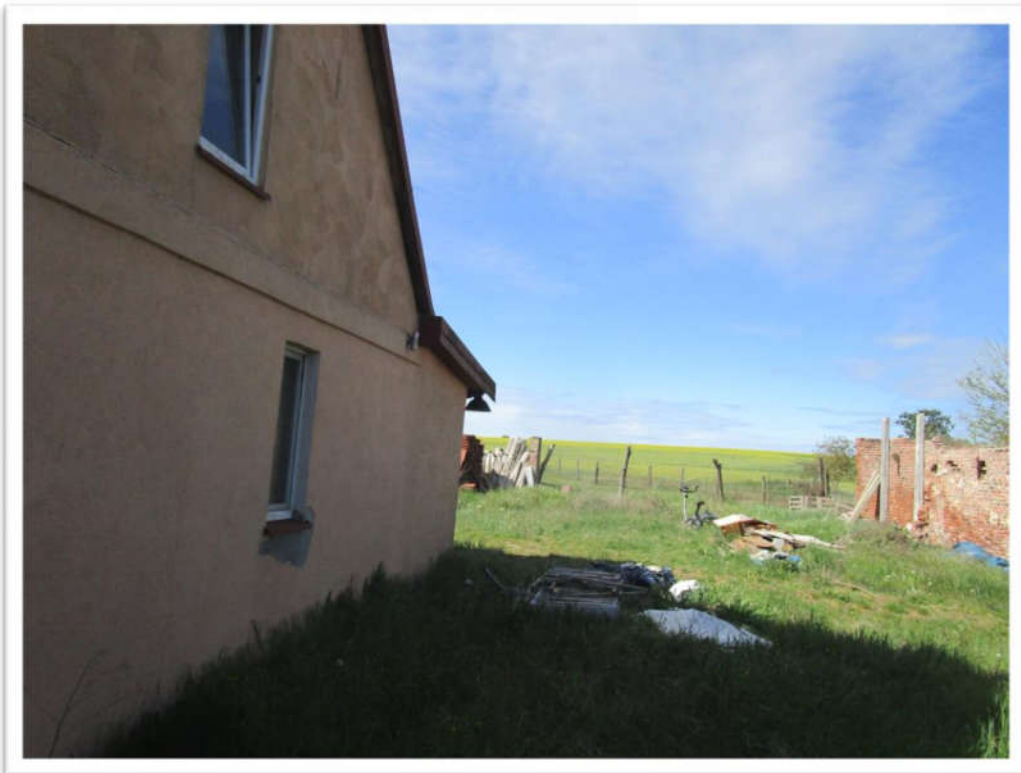
Bild 6: Wohnhaus nördliche Giebelseite und hinterer Grundstücksbereich
