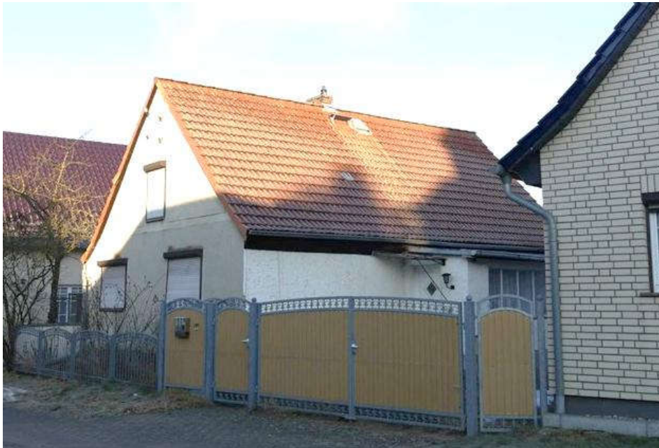
Bild 1: Vorderansicht mit Zufahrt zum Grundstück
