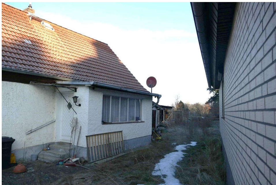
Bild 6: Bewertungsobjekt mit Umgebung in östliche Richtung
