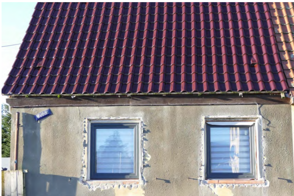
Bild 2: erneuerte Dachhaut, fehlende Regenentwässerung, Fenster modernisiert
