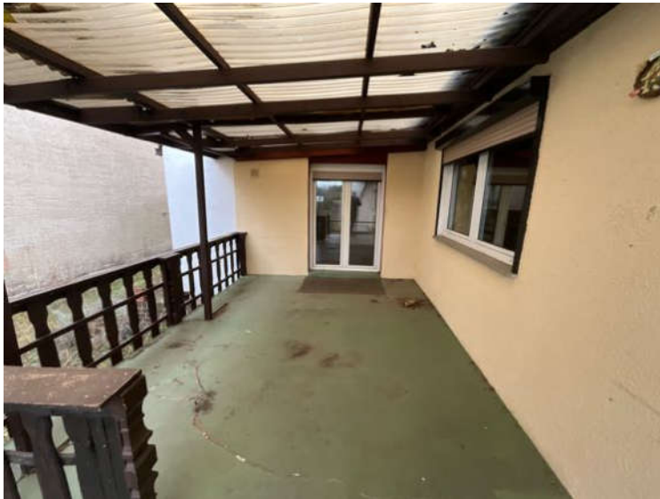
Bild 39: Terrasse und Eingangsbereich Wohnung (EG)
