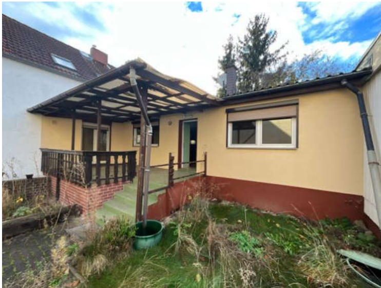
Bild 10: Anbau mit Zugang Wohnung (EG)
