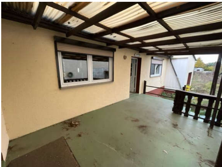
Bild 40: Terrasse und Eingangsbereich Wohnung (EG)
