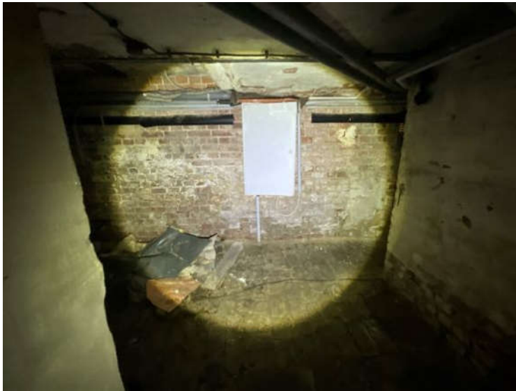
Bild 67: Kellerraum mit Elektroanschluss
