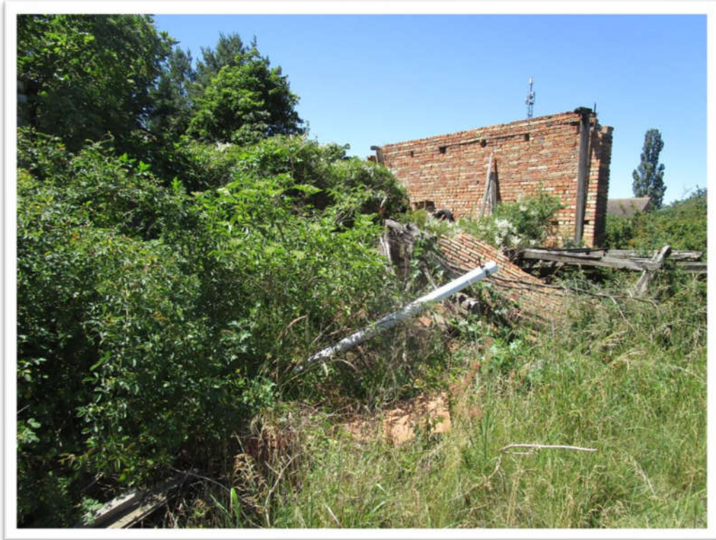
Bild 11: Ruine/ Nebengebäude Scheune
