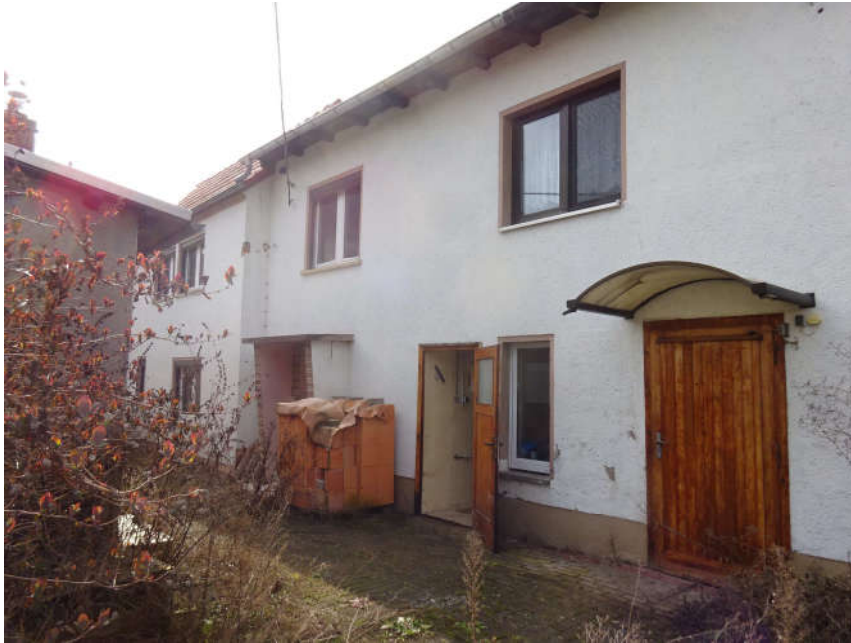
Bild 3: Wohnhaus aus nordöstlicher Richtung vom Hof aus
