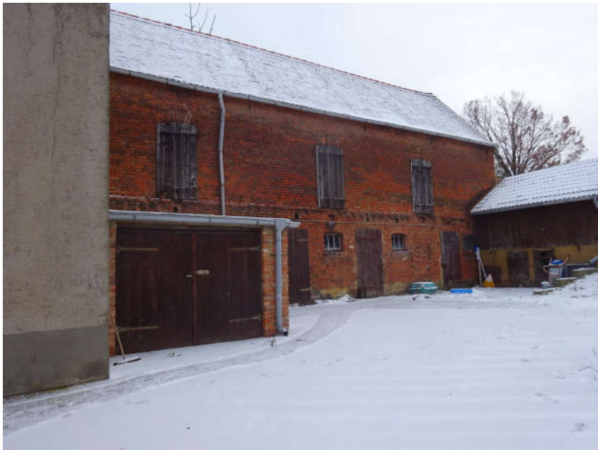
Bild 14: Nebengebäude Scheune, Garage und Schuppen
