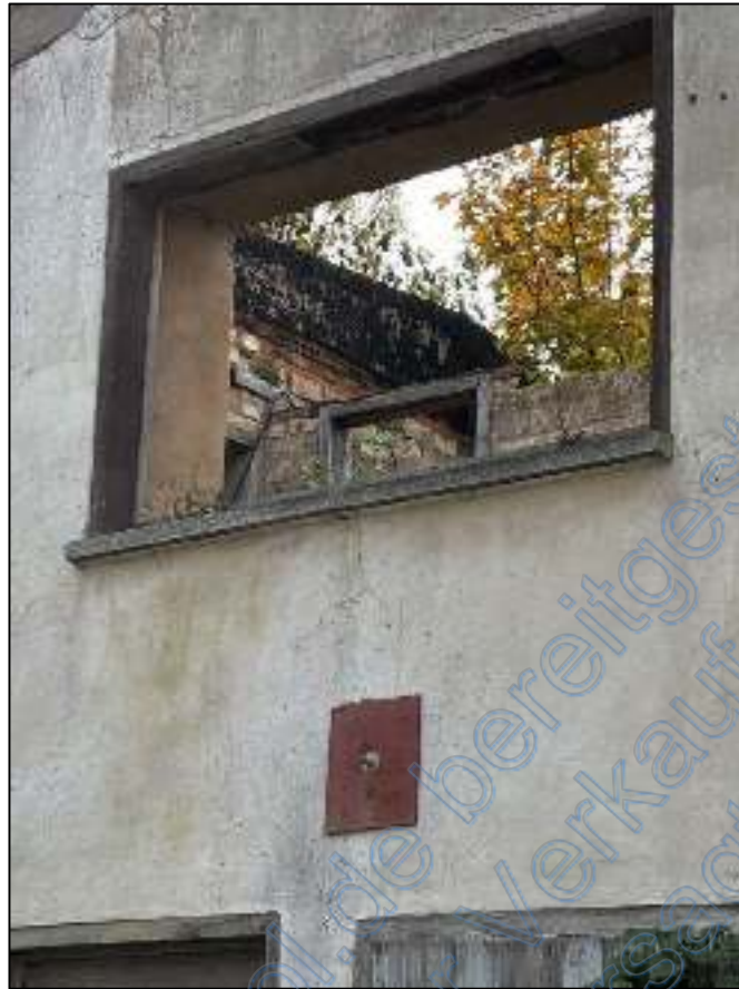
Bild 11: Detailansicht an der straßenseitigen Fassade des ehemaligen Gasthofs im Bereich des Seitenflügels
