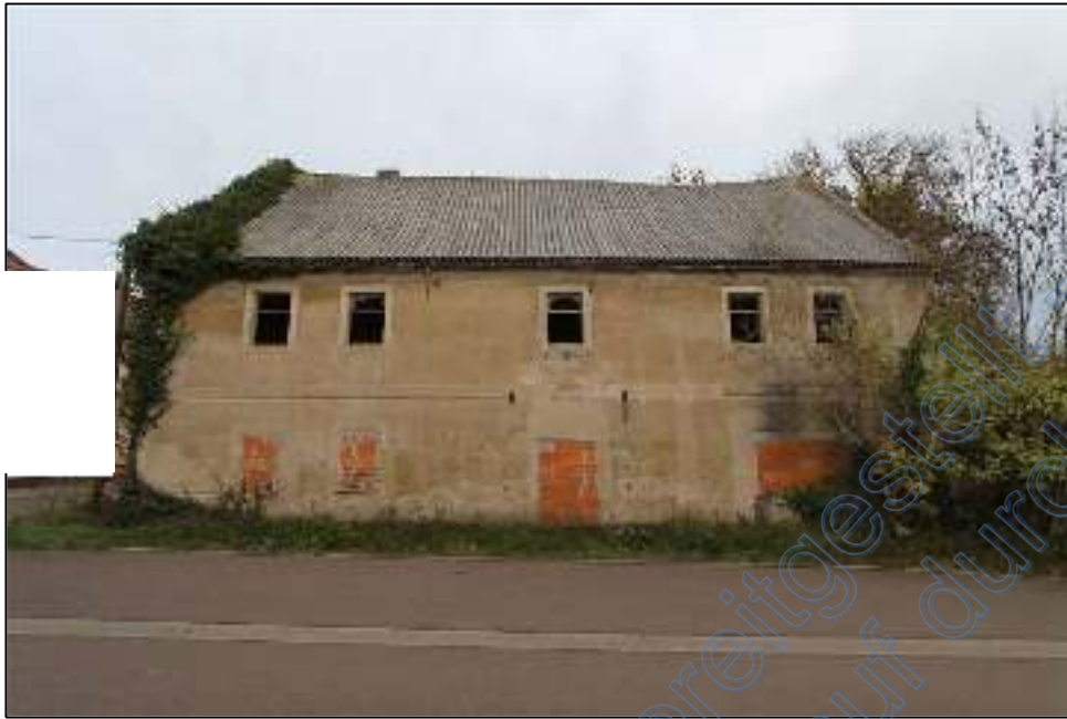
Bild 13: Ansicht der straßenseitige Fassade des ehemaligen Wohnhauses
