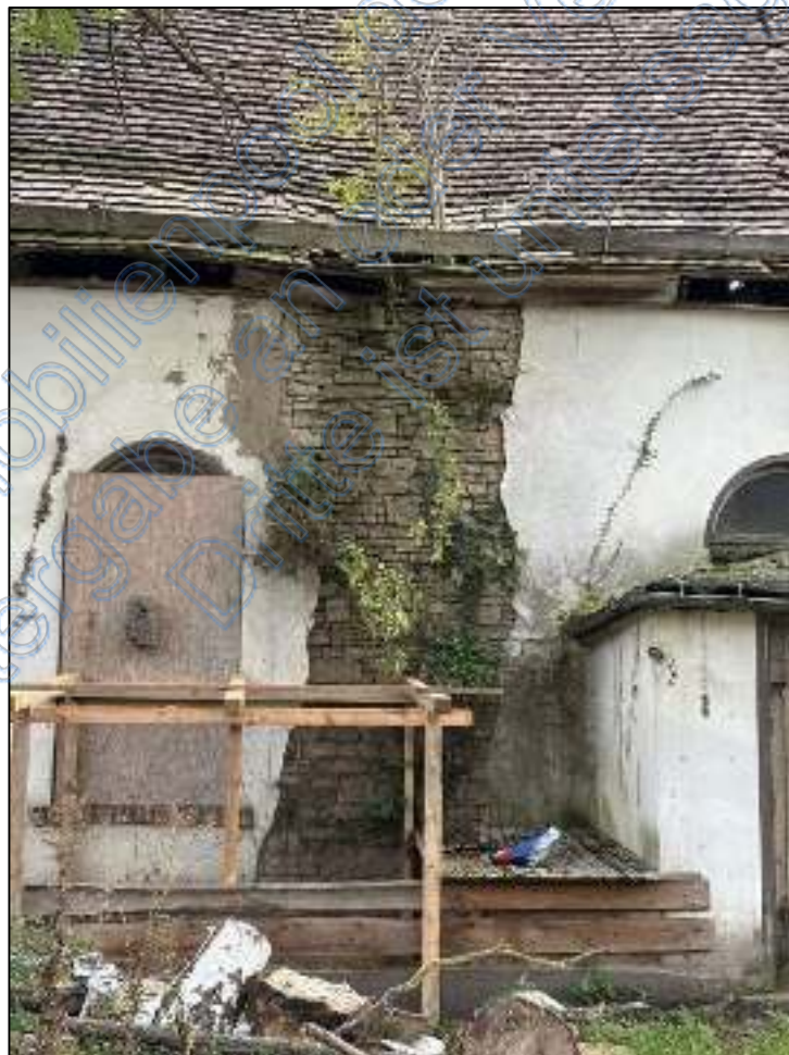
Bild 8: Detailansicht an der straßenseitigen Fassade des ehemaligen Gasthofs (Saalbereich)
