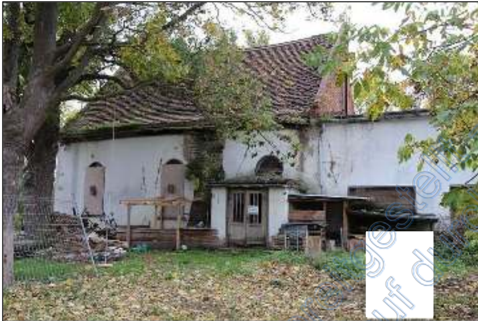
Bild 7: Vorderansicht des ehemaligen Gasthofs (Saalbereich)
