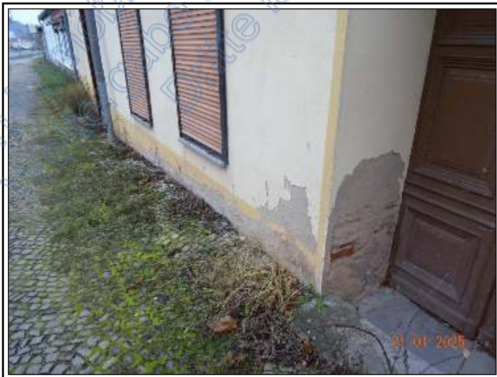
Foto 10: Schäden am straßenseitigen Sockel des Wohnhauses
