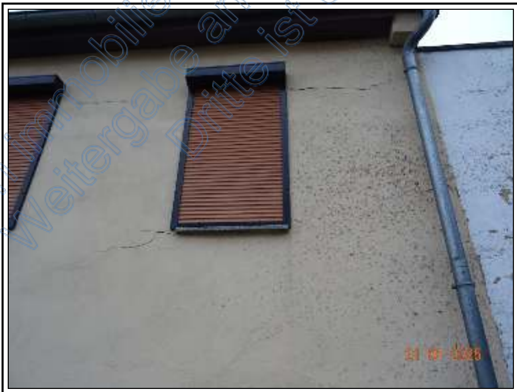
Foto 12: Putzschäden an der straßenseitigen Fassade des Wohnhauses
