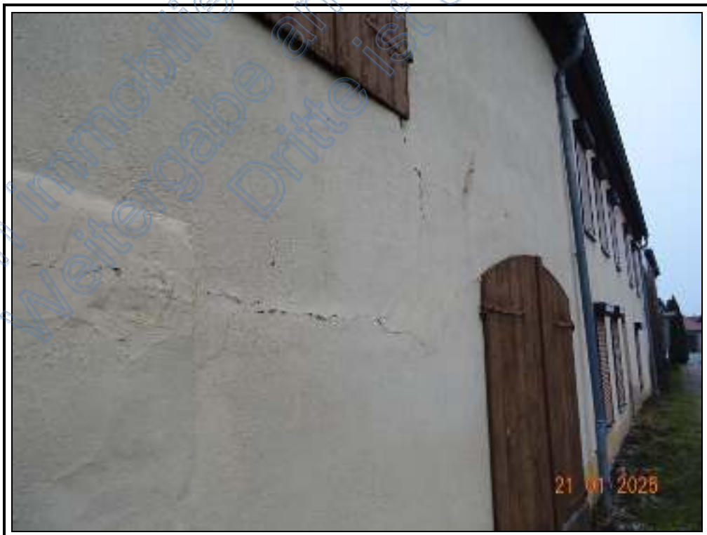
Foto 18: Putzschäden an der straßenseitigen Fassade des Wirtschaftsgebäudes
