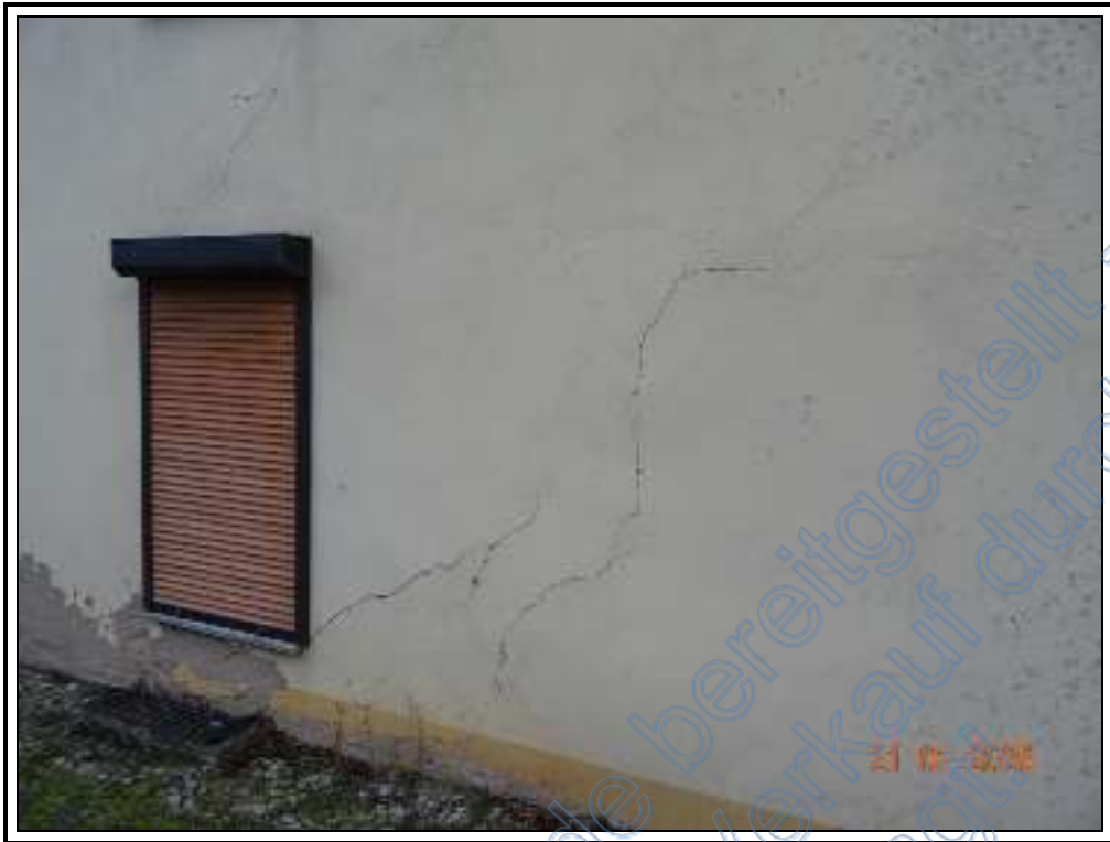
Foto 11: Putzschäden an der straßenseitigen Fassade des Wohnhauses
