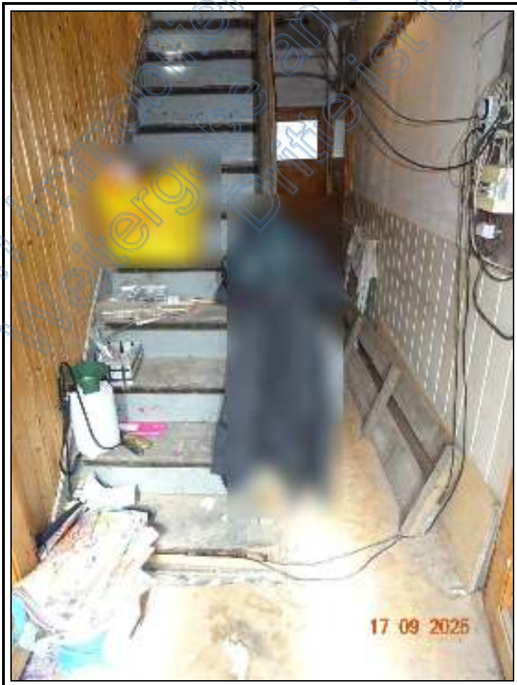
Foto 10: Flur im EG des EFH
