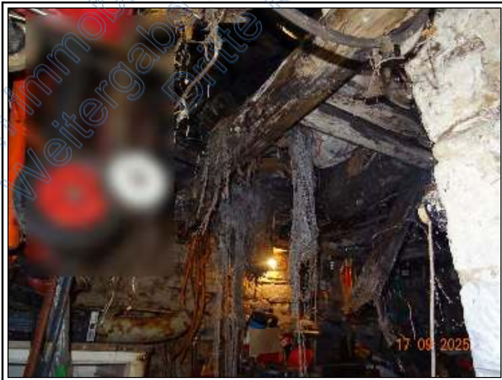
Foto 34: beispielhafte Innenansicht des Nebengebäudes
