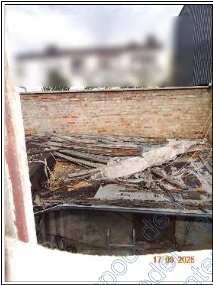
Foto 29: Draufsicht des Nebengebäudes
