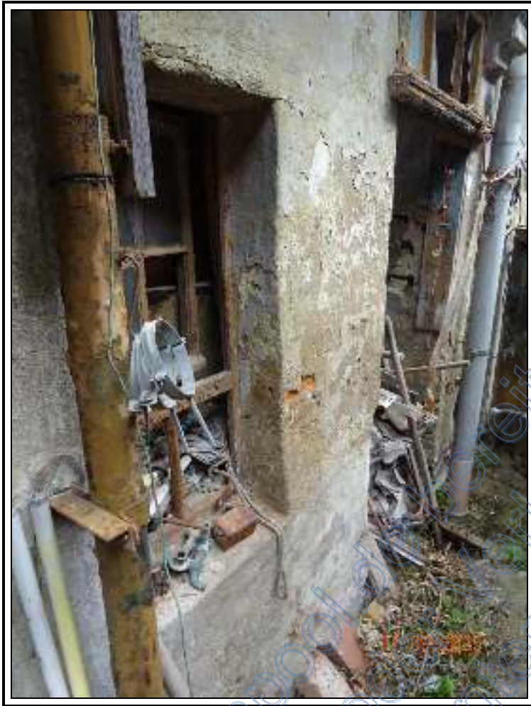
Foto 31: hofseitige Teilansicht des Nebengebäudes
