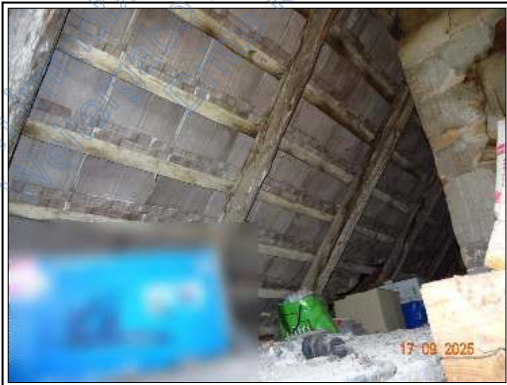
Foto 26: Spitzboden des EFH
