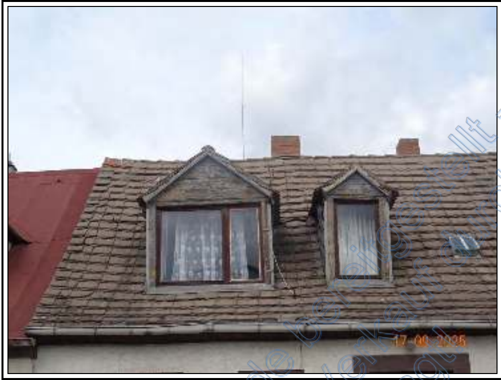
Foto 5: Detailansicht: Dach und straßenseitige Gauben des EFH
