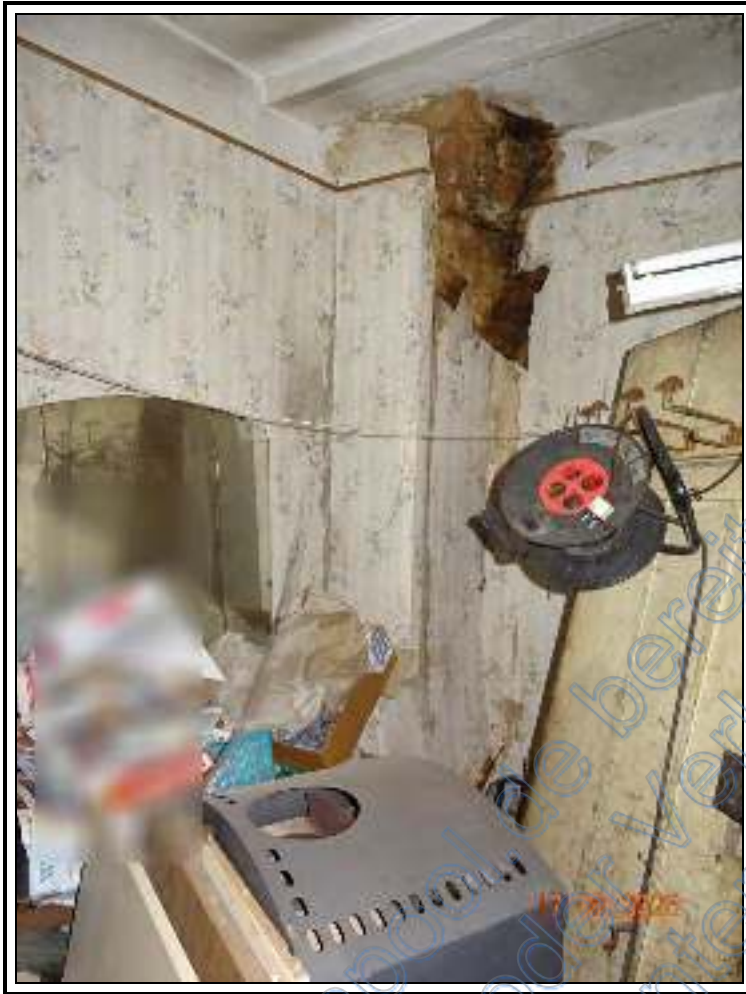
Foto 17: Zimmer im EG des EFH
