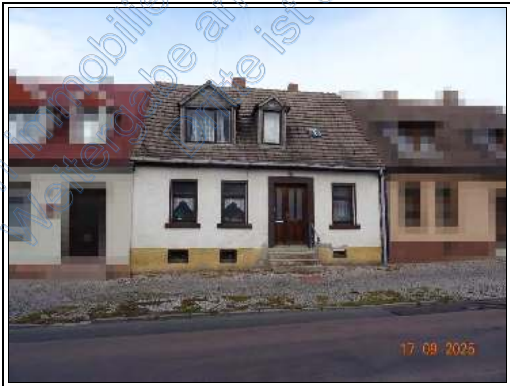
Foto 2: südliche Ansicht des Einfamilienhauses (EFH)
