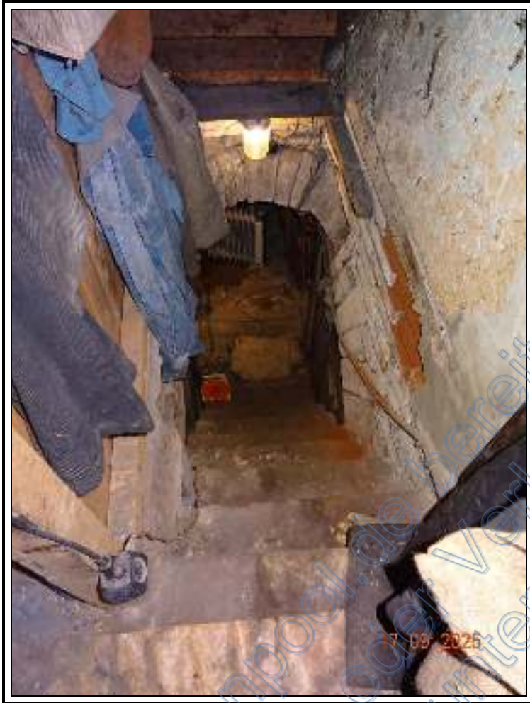
Foto 7: Kellertreppe des EFH
