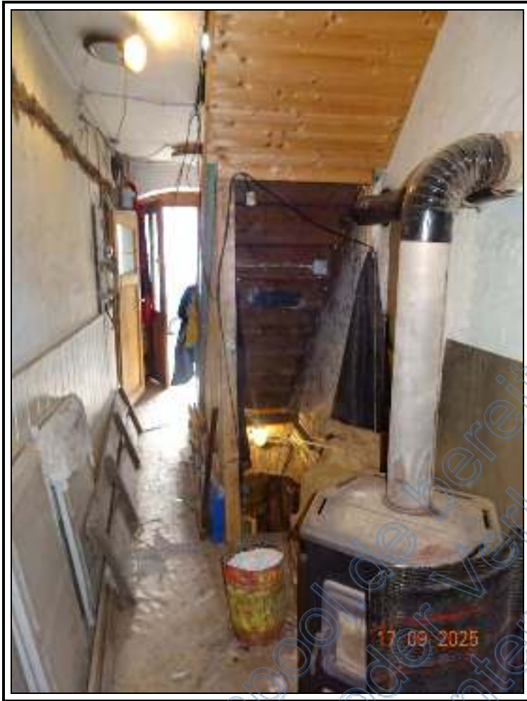
Foto 11: Flur im EG des EFH
