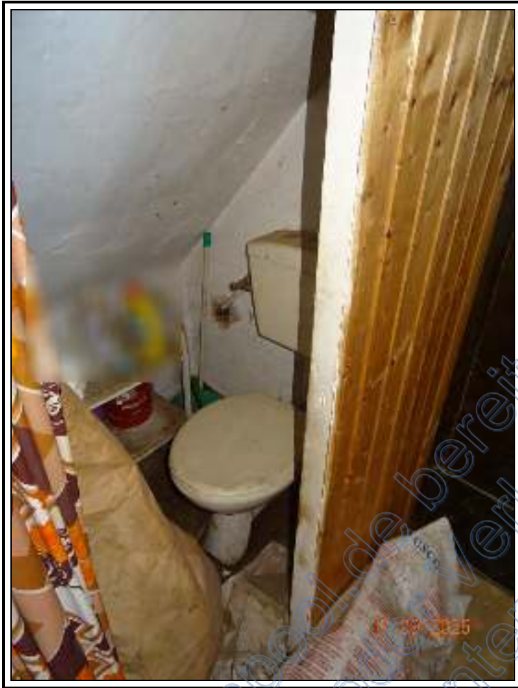
Foto 21: WC im DG des EFH
