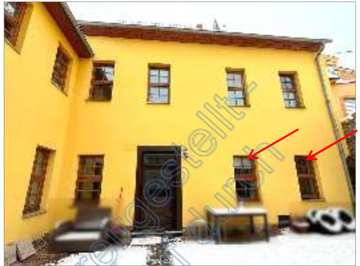
Hinterfront des Mehrfamilienhauses und Lage der WE Nr. 2 im EG links
