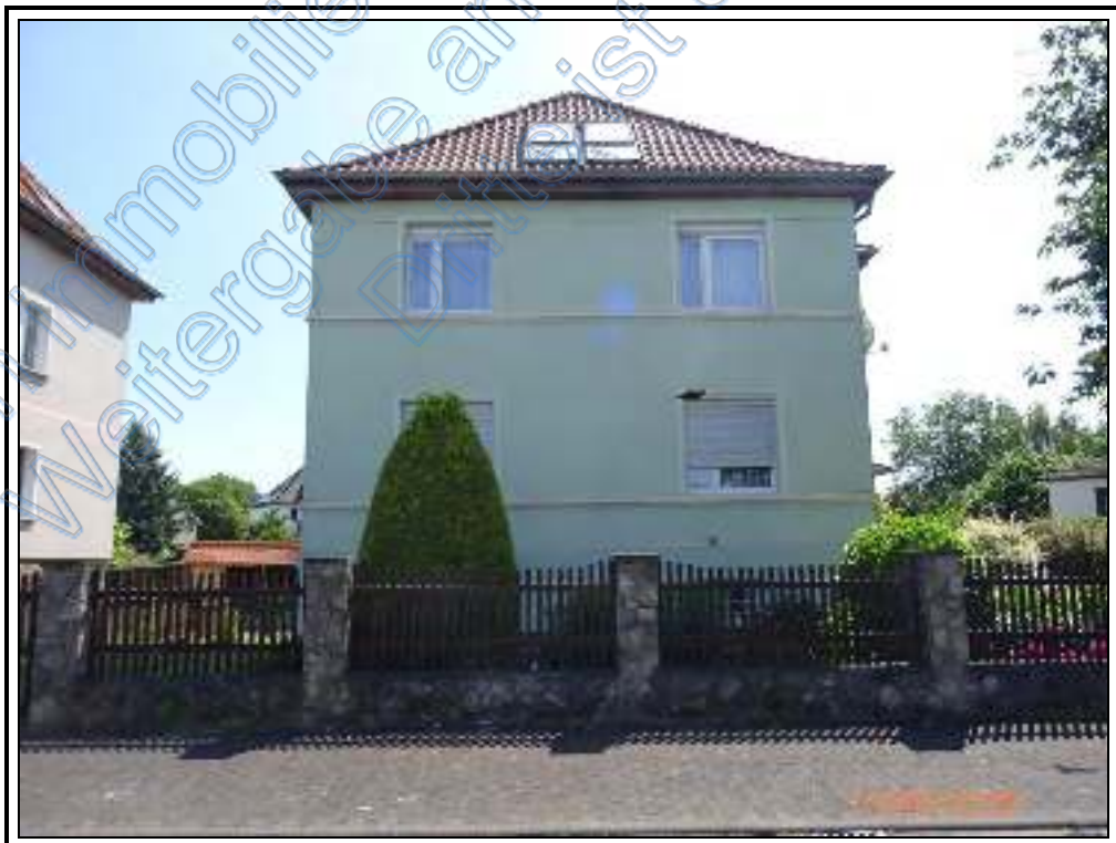
Foto 4: westliche Ansicht des Zweifamilienhauses
