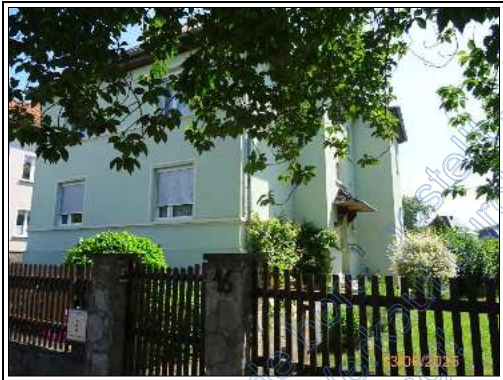
Foto 7: westlicher Grundstücksbereich mit Zugang von der Anliegerstraße
