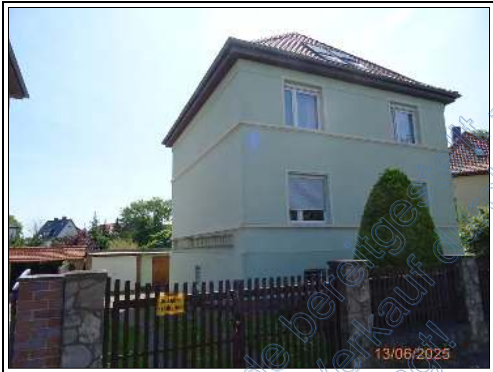
Foto 3: nordwestliche Ansicht des Zweifamilienhauses und der Doppelgarage
