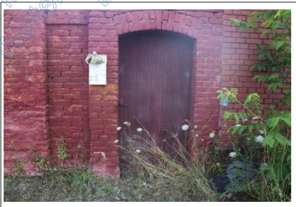
Detailansicht vom Hofzugang
