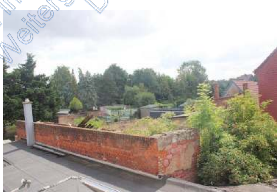
Ansicht vom Grundstück in östliche Richtung mit ruinösen Schuppengebäuden
