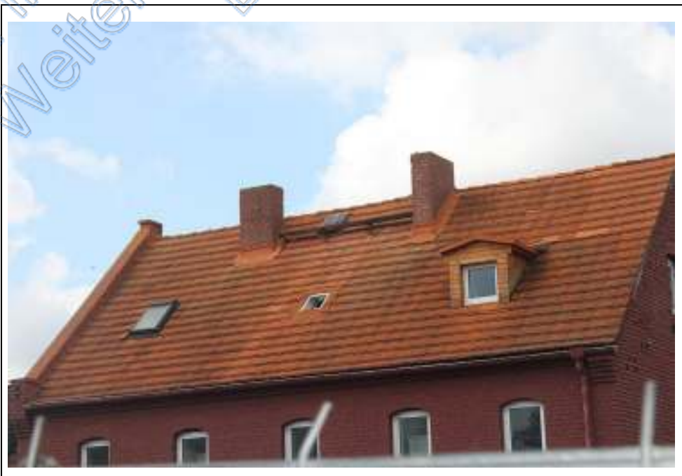
Detailansicht der hofseitigen Dachfläche mit offenen Dachfenster
