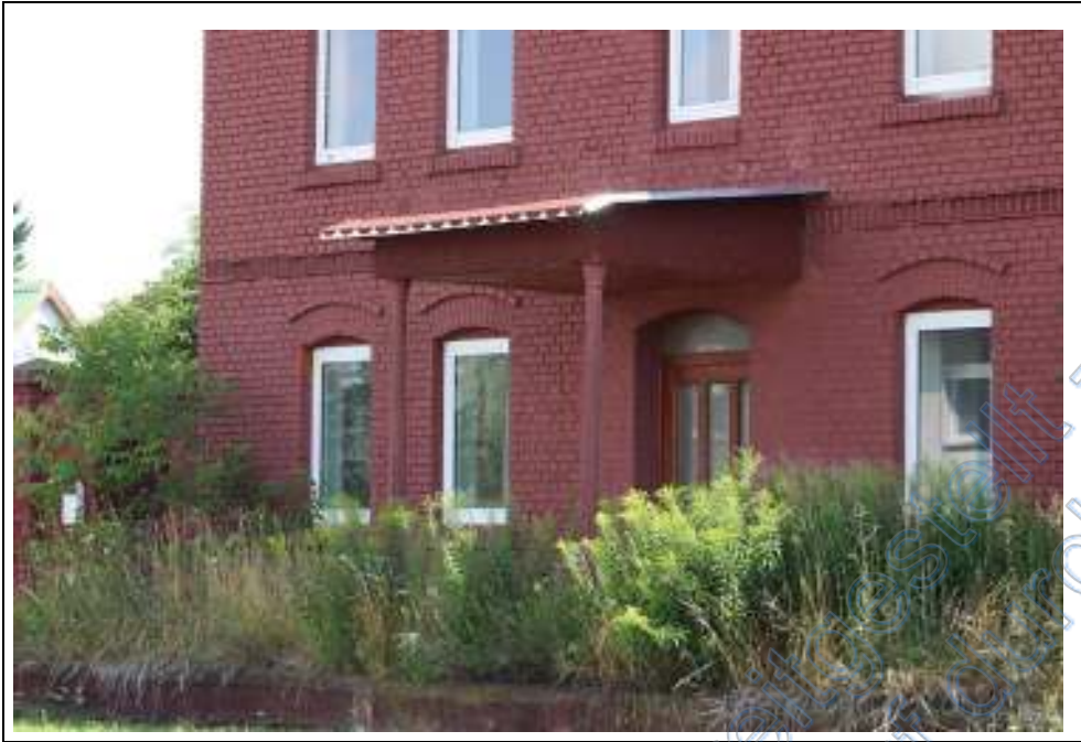
Detailansicht vom Eingangsbereich
