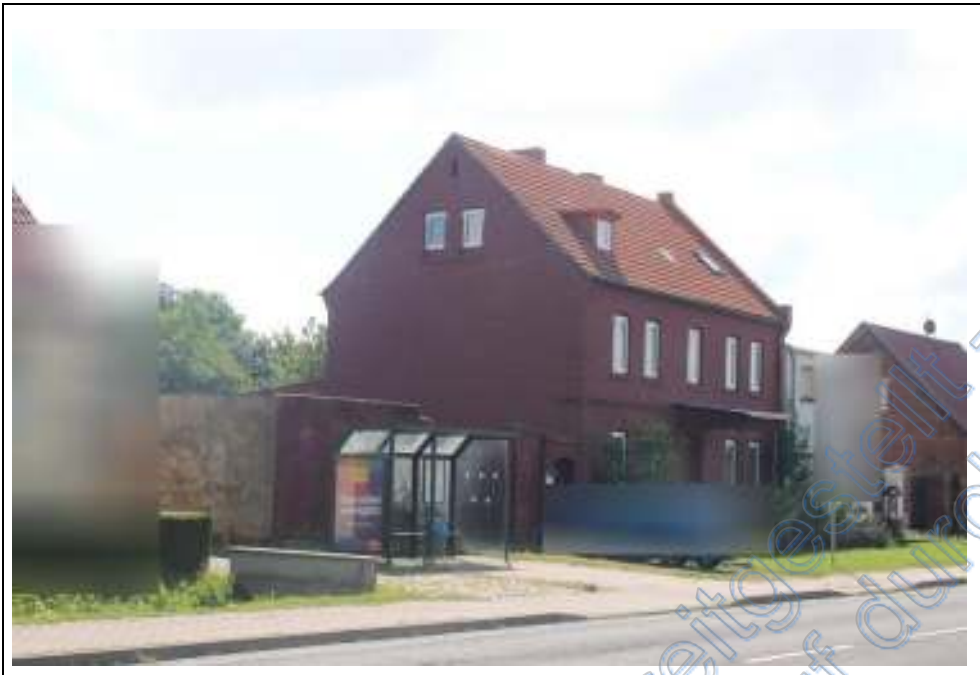
Ansicht der Nord- fassade
