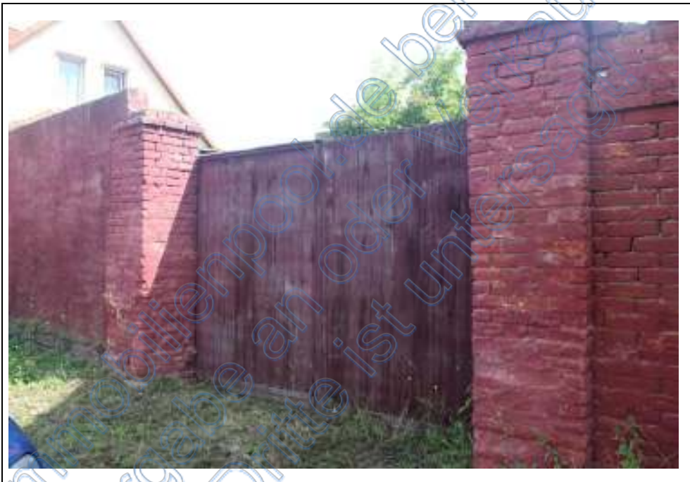
Detailansicht von der Hofzufahrt
