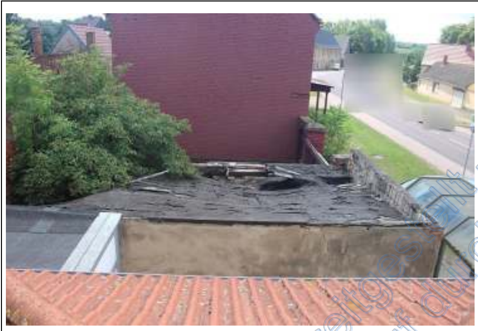
Ansicht vom ruinösen Schuppengebäude
