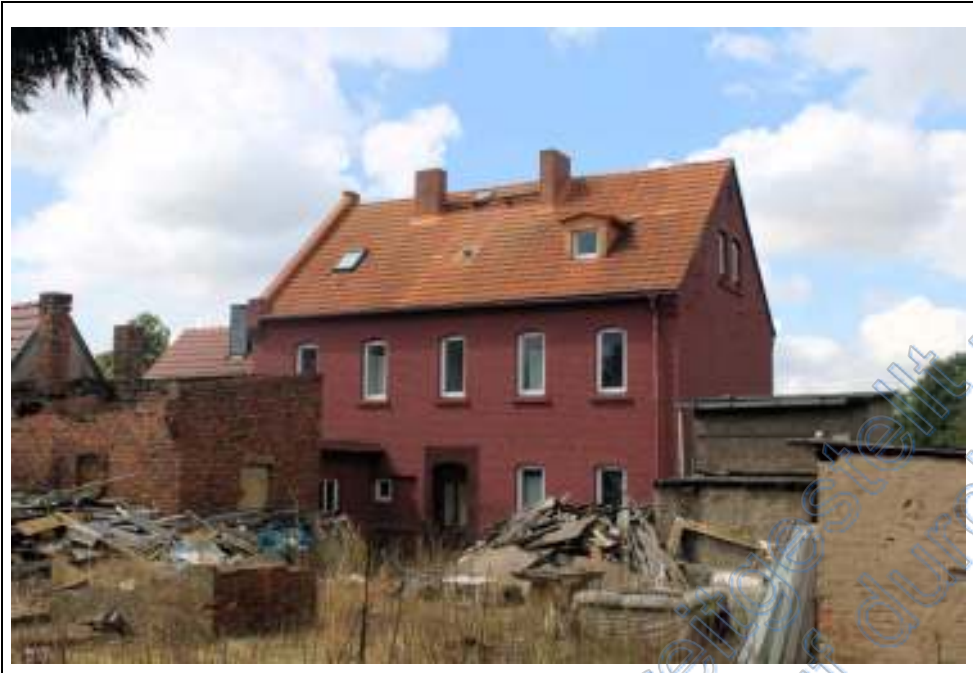
Rückansicht vom Wohngebäude und den Bauschuttalagerungen im Hof-/Gartenbereich
