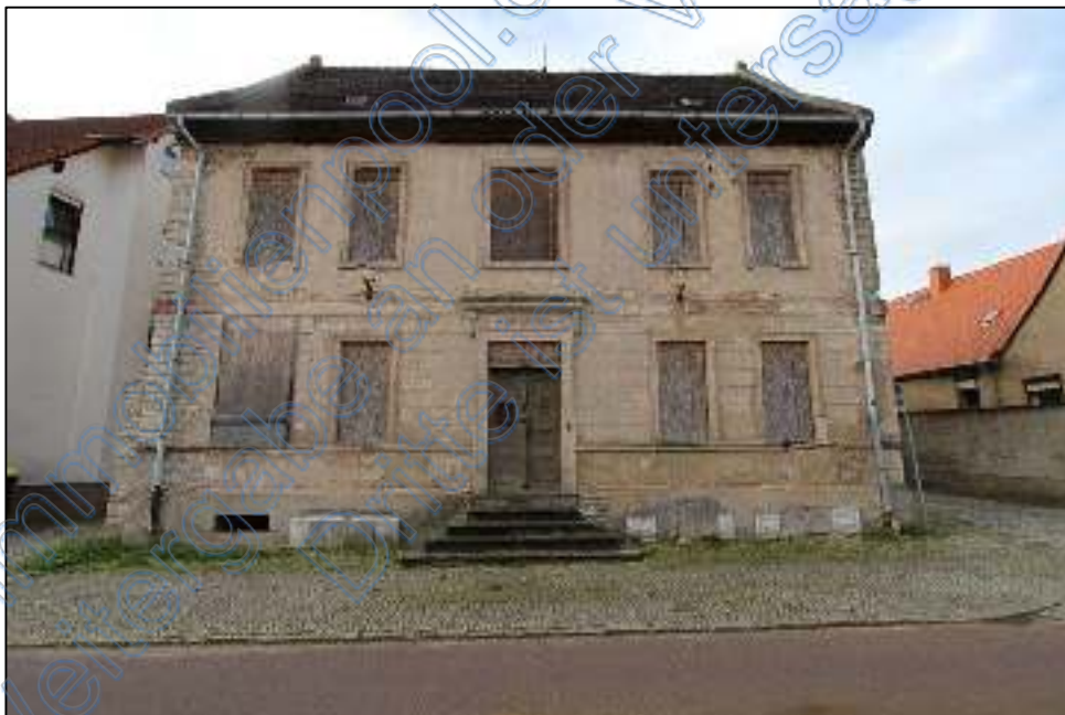
Bild 4: Vorderansicht des Wohnhauses
