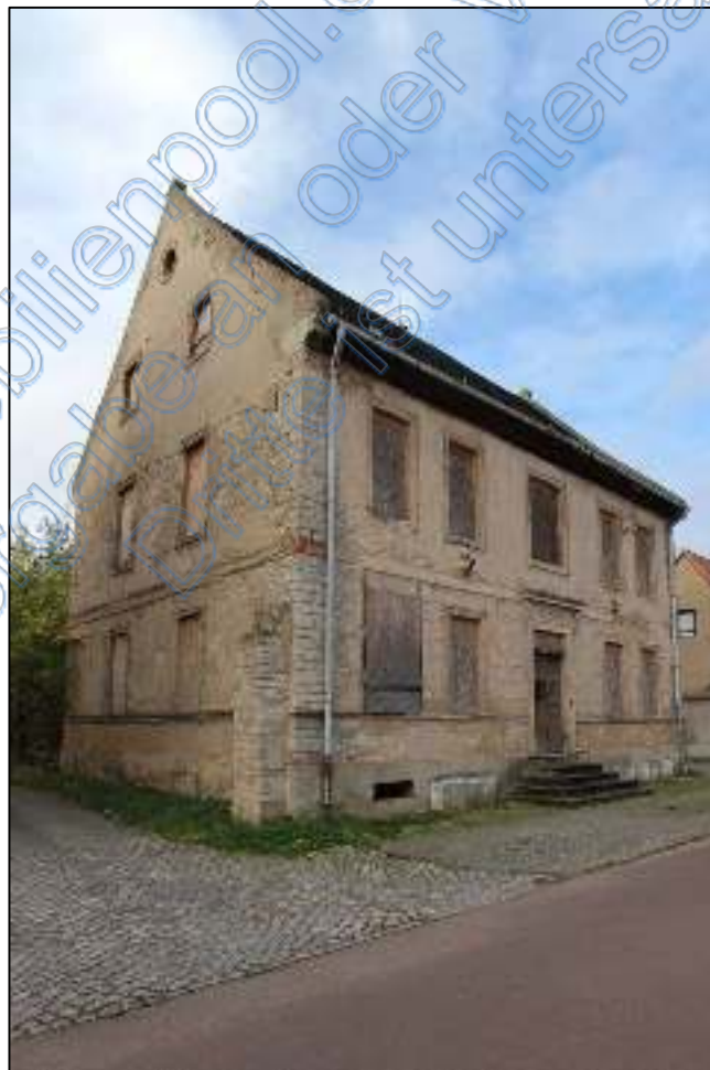
Bild 8: östlicher Giebel des Wohnhauses von der Straße aus
