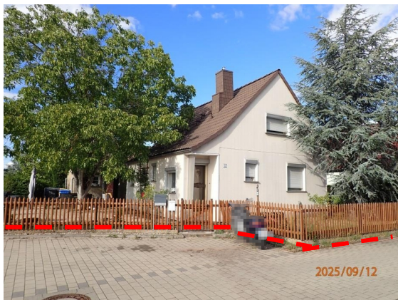
Wöhlerstraße 1 / Ansicht von der Wöhlerstraße Blick in etwa Richtung Norden
