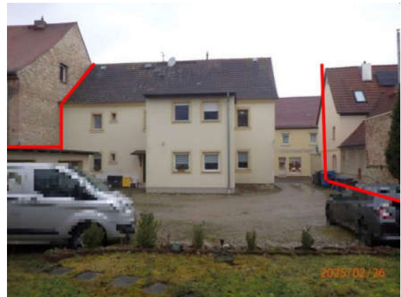
Blick über das Grundstück auf die Hausrückseite SO-orientierte Fassade
