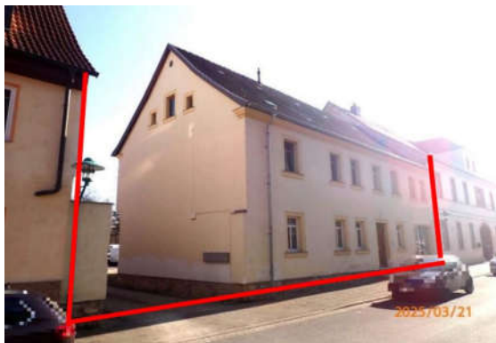
Ansicht von der Straße - mit Zufahrt zum Grundstück Straßenseite etwa NW-orientierte Fassade
