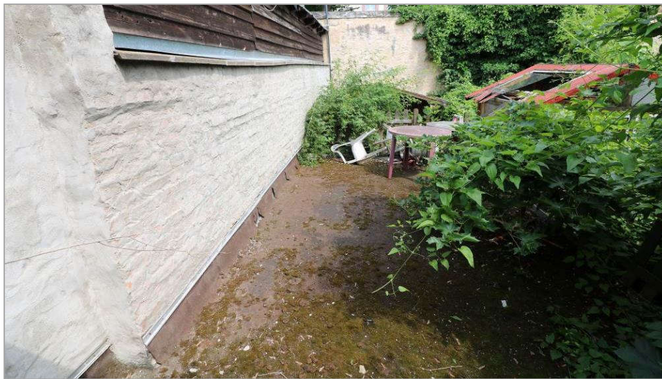
Nebengebäude 1 (Anbau/Lager/Abstell) - Dachansicht
