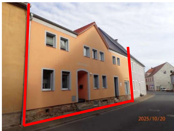
Südfassade Blick in etwa Richtung Nordosten
