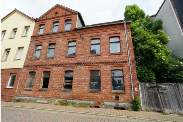
straßenseitige Ansicht des Wohnhauses
